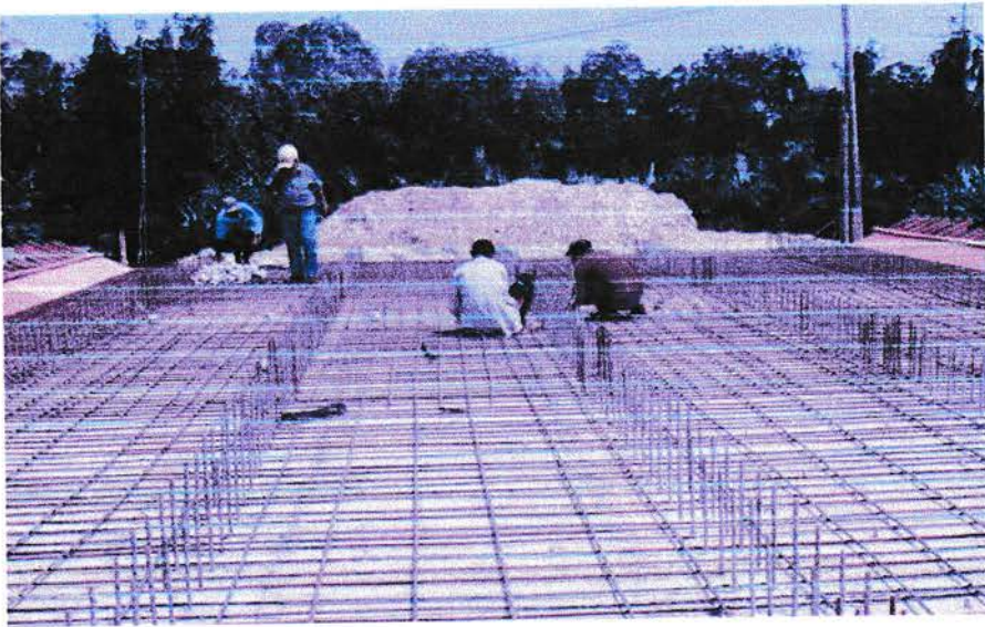
Gbr 4 : Pengerjaan Pembesian Lantai
