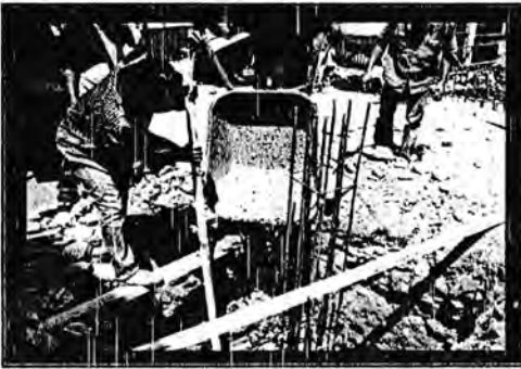
Gambar 4.2a. Proses pengecoran pondasi
