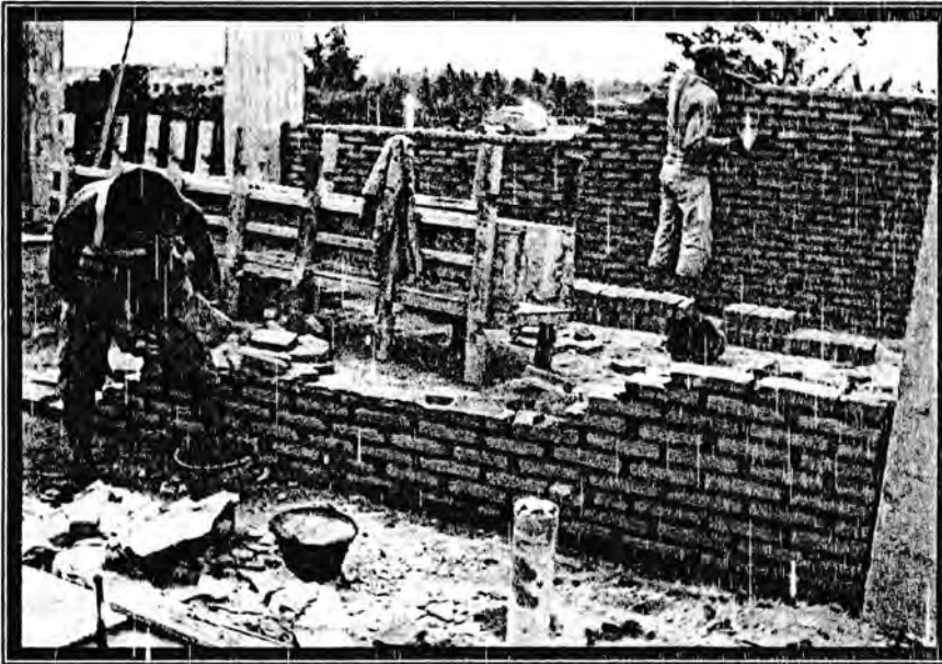
Gambar 4.8. Proses pemasangan bata
