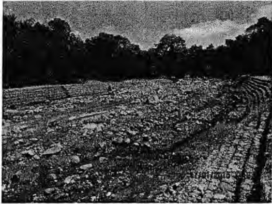
Pembuatan Tanggul Bronjong Sepanjang 2.274 Meter
