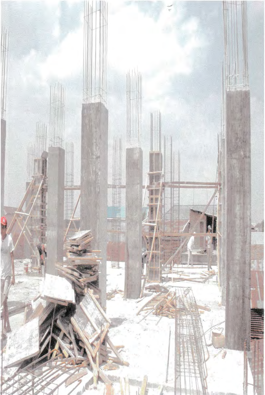
Gambar 10: Pembongkaran Bakisting Kolom.
