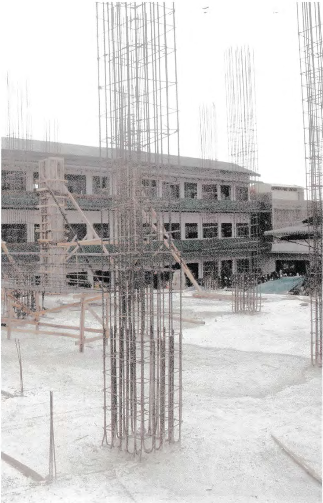
Gambar 3: Berdirinya Tulangan Kolom
