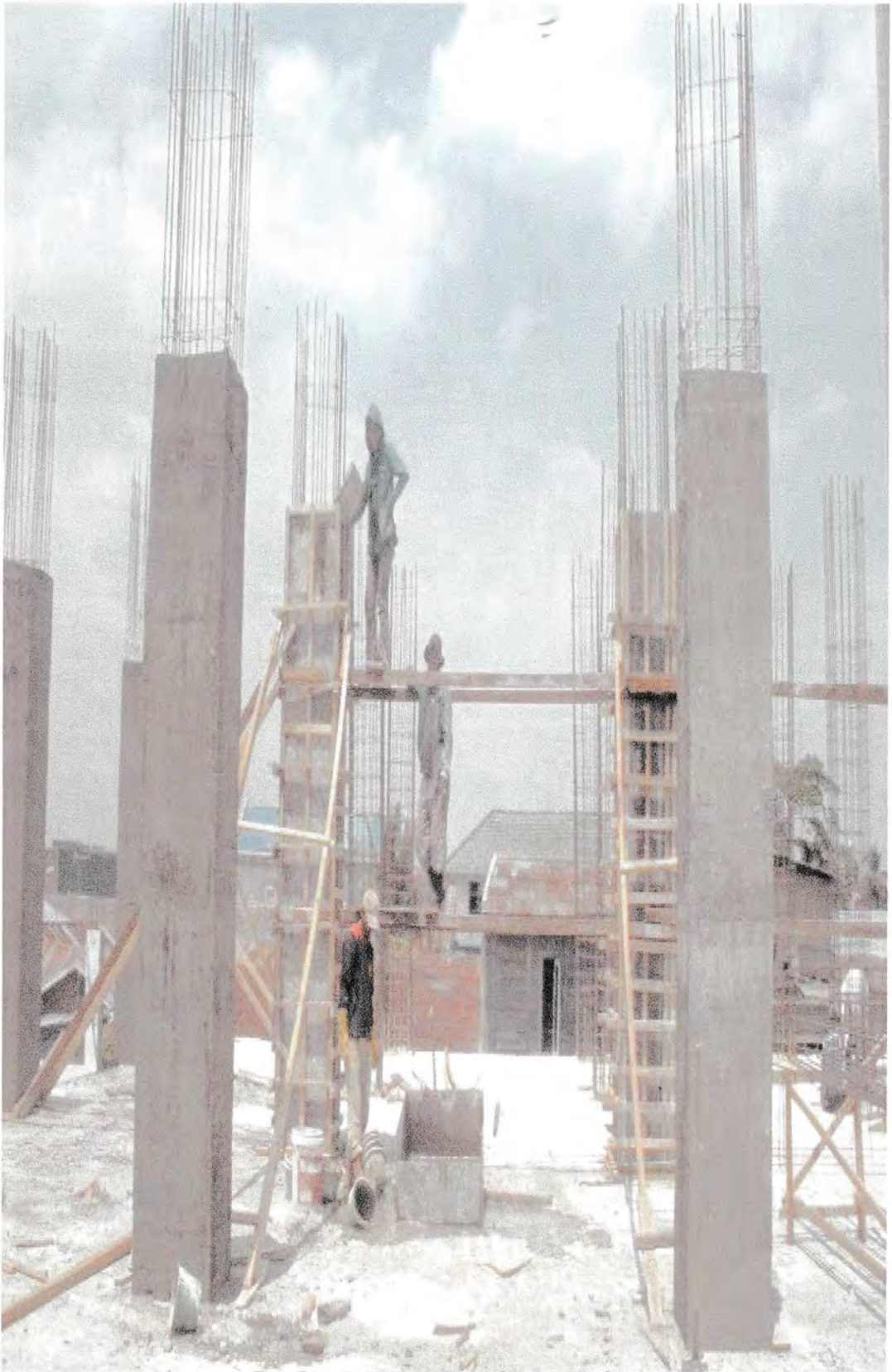
Gambar 7: Proses Pengecoran Kolom
