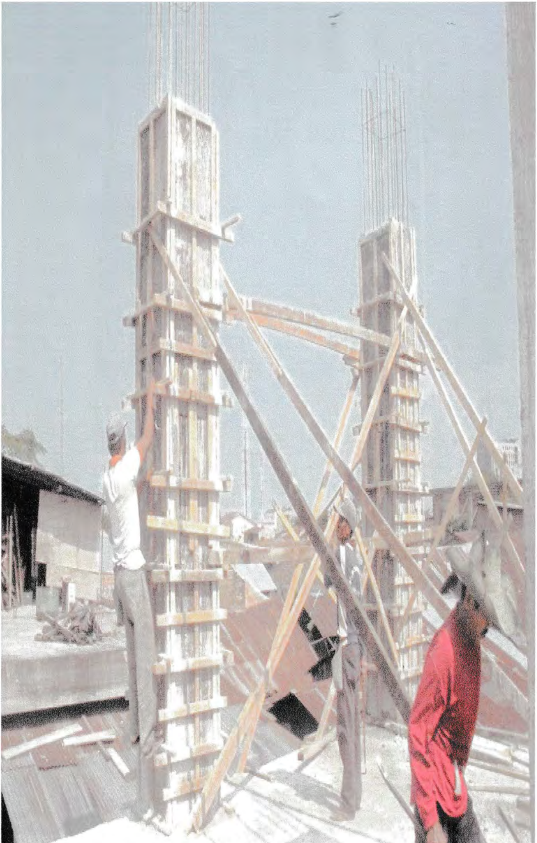
Gambar 11: Pembongkaran Bakisting Selanjutnya.
