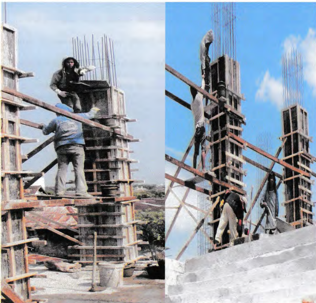
Gambar 5 :Proses Pengecoran Kolom
