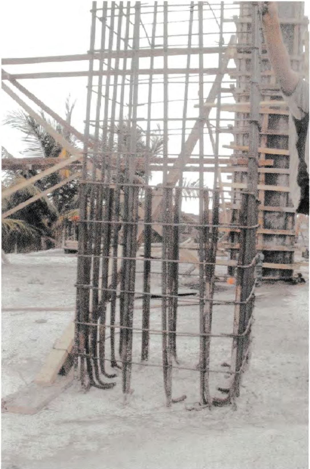
Gambar 4: Detail Berdirinya Tulangan Kolom
