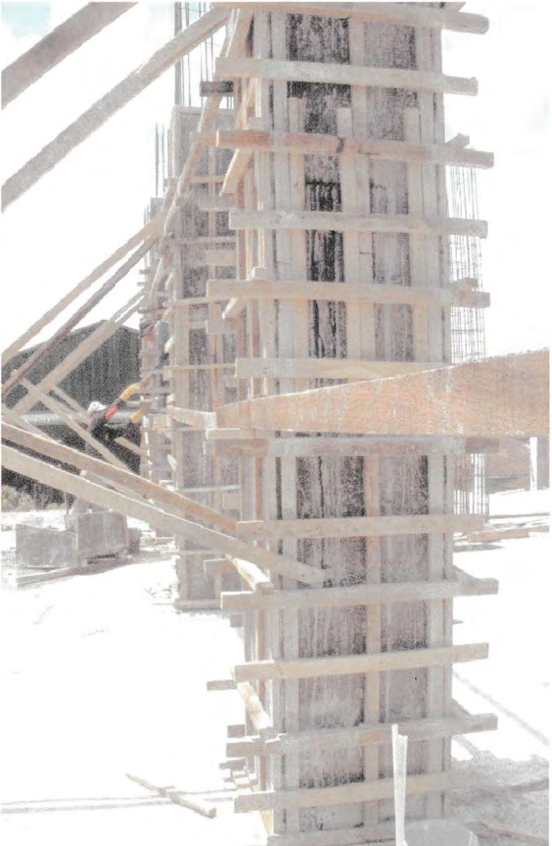
Gambar 6: Proses Pengeringan Kolom
