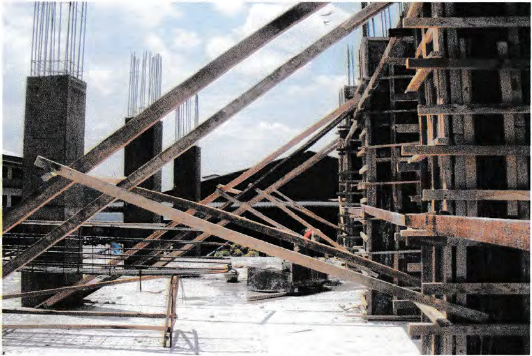
Gambar 6 :Proses Pengeringan Kolom
