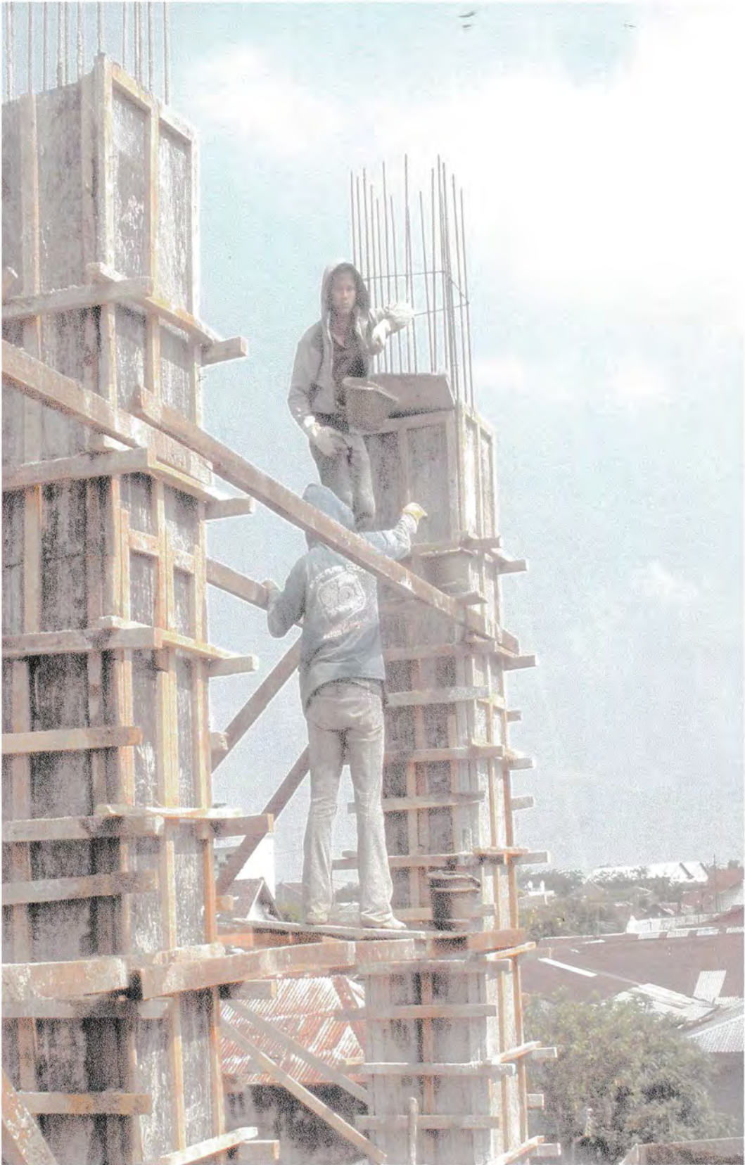
Gambar 8: Pengecoran Selanjutnya.
