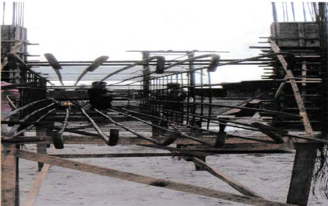
Gambar 2 : Tulangan Kolom Tampak depan
