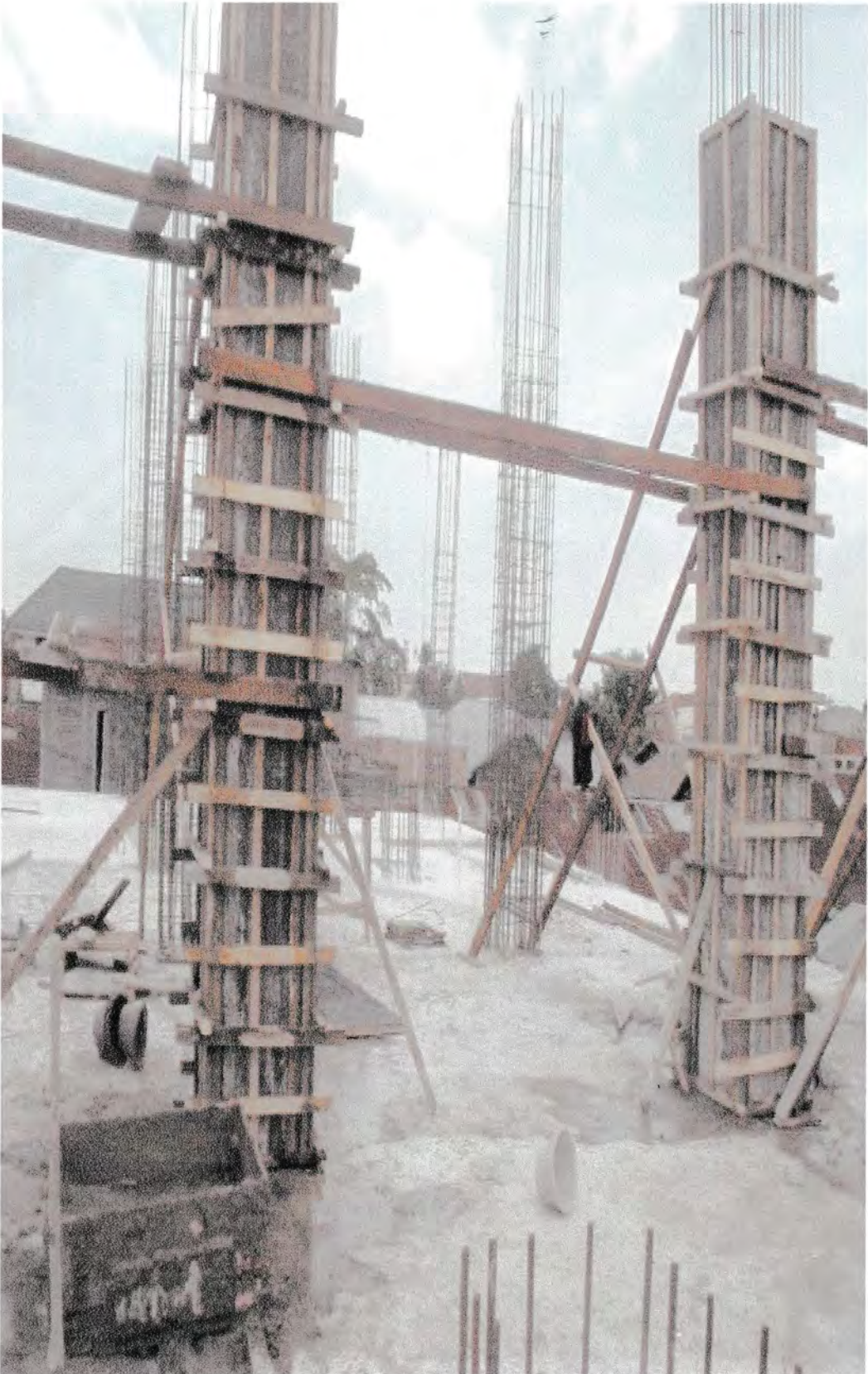
Gambar 5: Proses Pemasangan Bakisting dan Pengcoran
