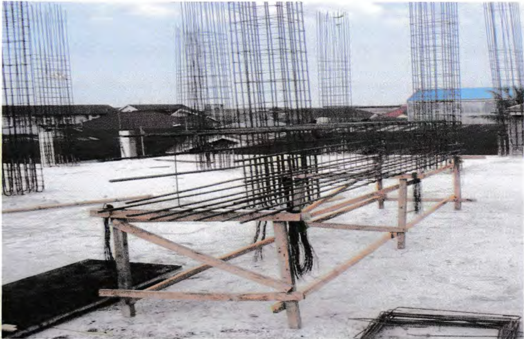
Gambar 3 : Tulangan Kolom Tampak Samping
