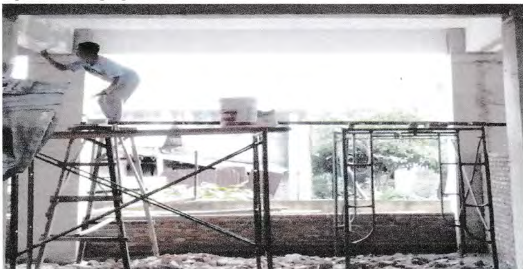
Gambar: 2.5.8a. Scaffolding
