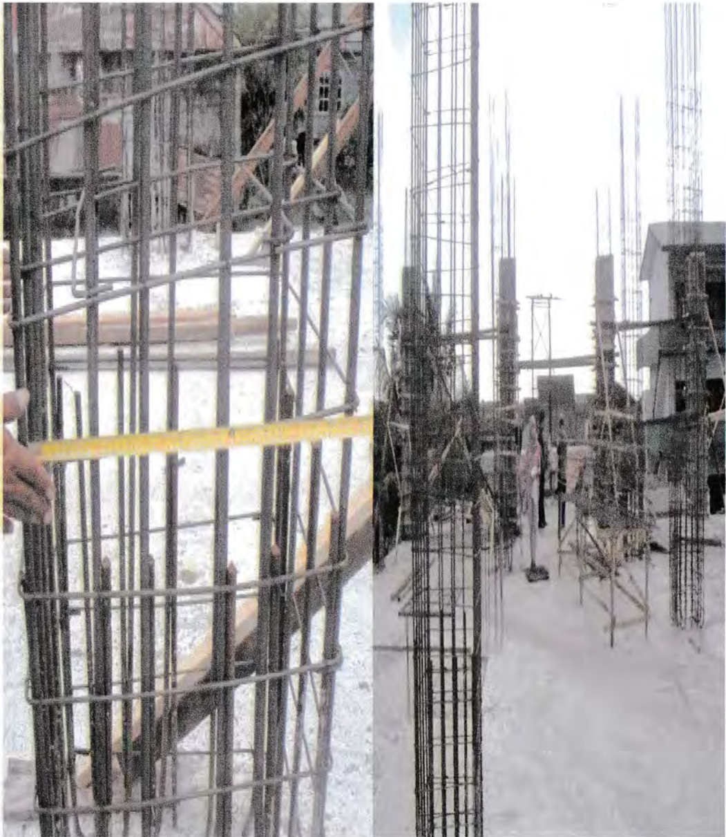
Gambar : Berdirinya Tulangan Kolom
