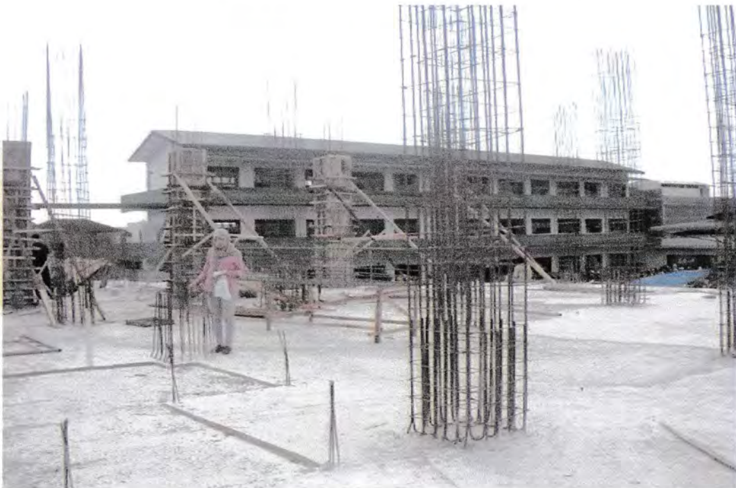
Gambar 4 : Tulangan Kolom yang sudah berdiri
