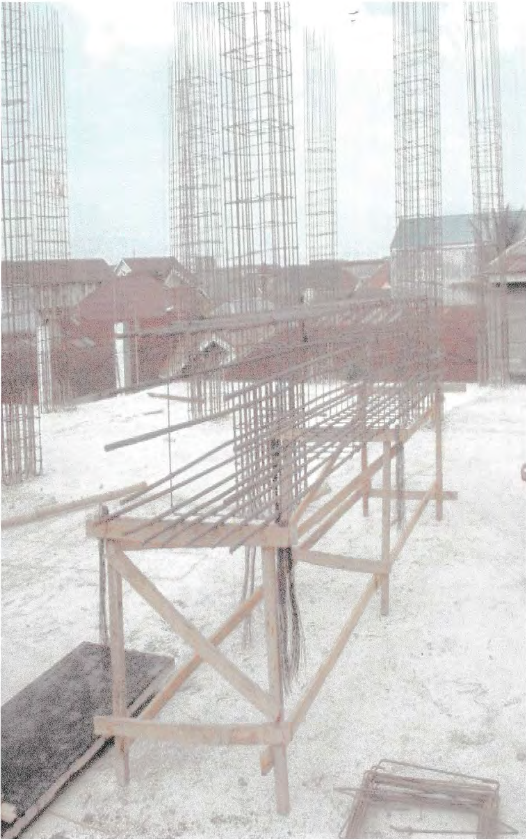
Gambar 2: Rangkaian Kolom
