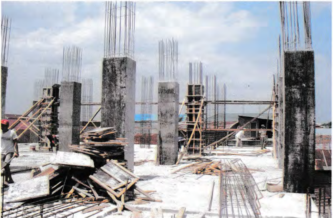
Gambar 7 : Pembongkaran Bakisting
