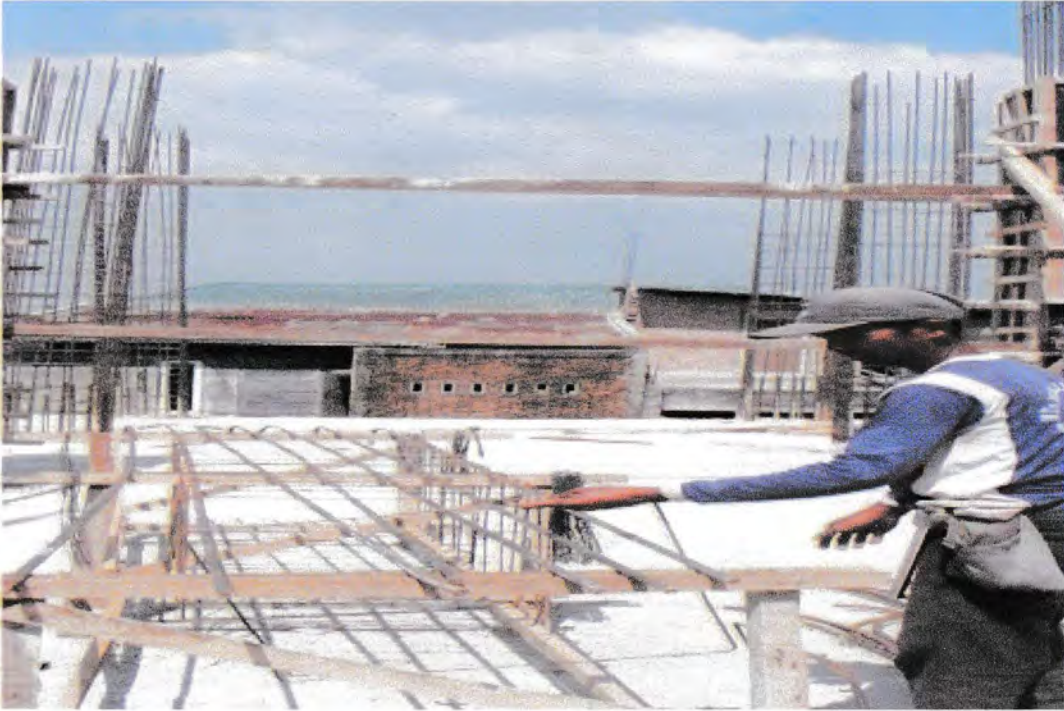
Gambar 1 : Merangkat Tulangan Kolom
