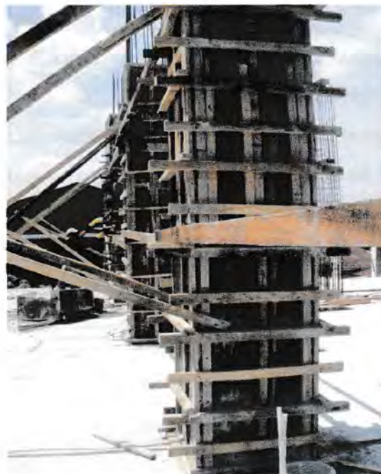
Gambar 2.9 Pemasangan bekisting
