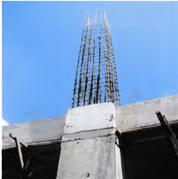
Gambar 2.3 Tulang kolom setelah dipasang
