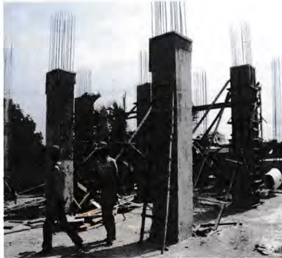
Gambar 2.11 Pembongkaran bekisting
