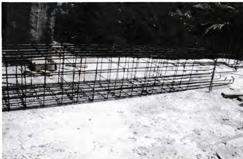
Gambar 2.2 Tulangan kolom sebelum dipasang
