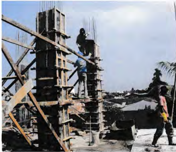
Gambar 2.10 Pengecoran kolom
