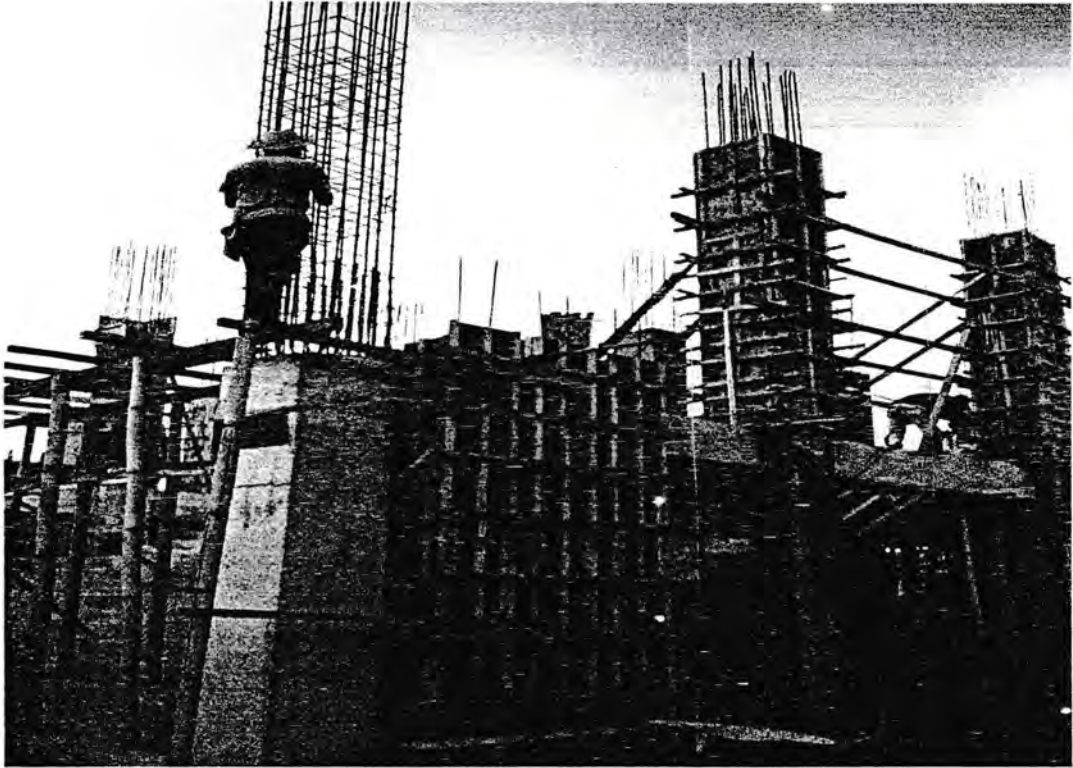
Gambar 2.4.1. Bekisting Kolom
