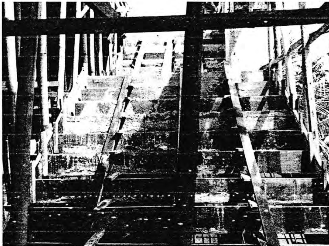
Gambar 18. Pemasangan Bakisting dan Pembesian Tangga Lokasi : Jalan Garu Ila No. 52 Kampus C Simpang Limun, 2014
