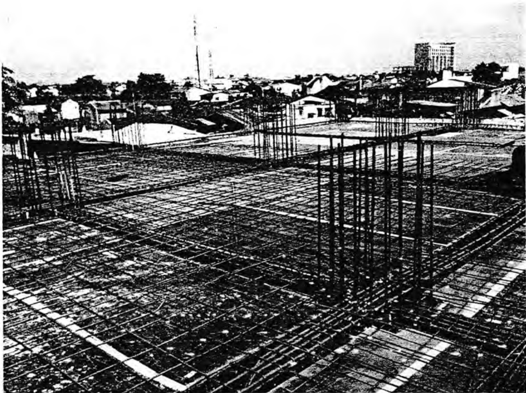
Gambar 19. Pemasangan Bakisting dan Pembesian Lantai
