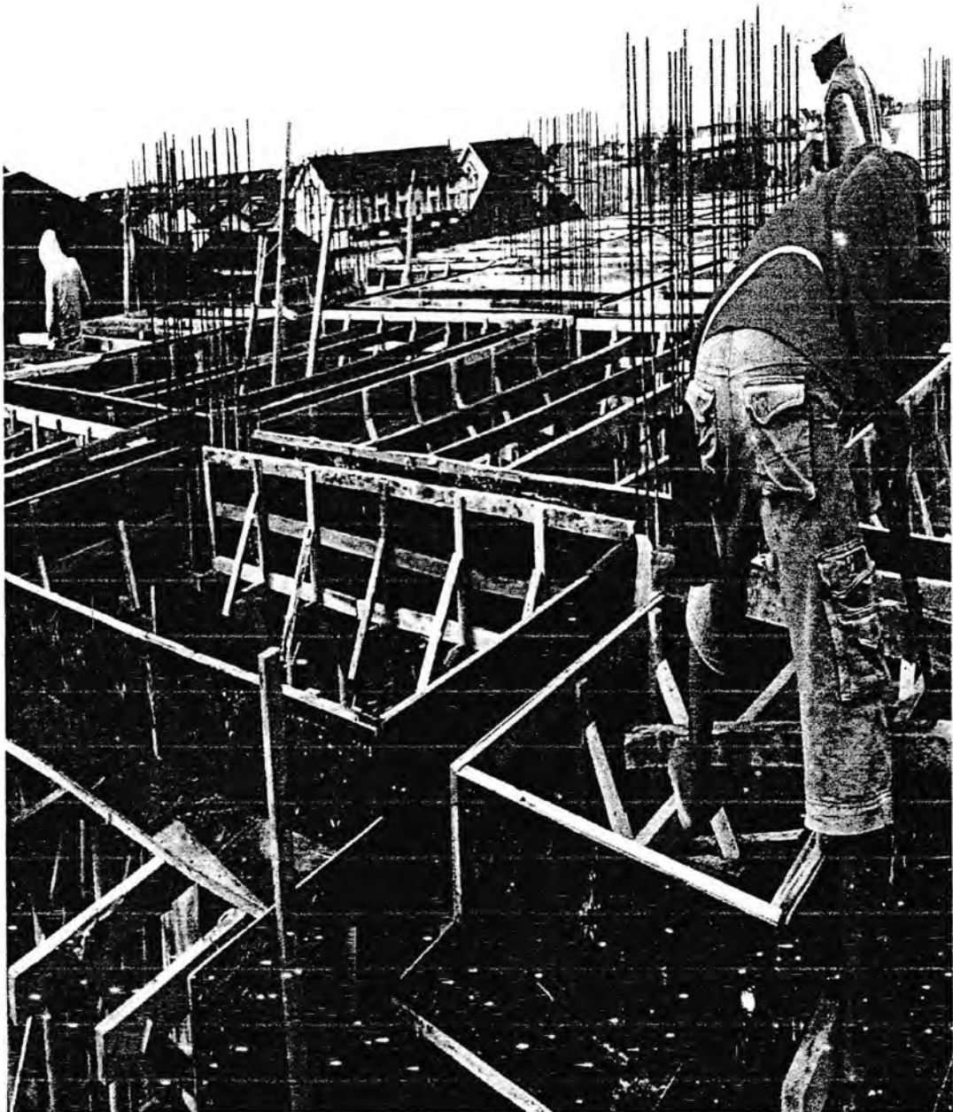
Gambar 16. Proses Bakisting Balok Tampak Atas Gedung Lokasi : Jalan Garu Ila No. 52 Kampus C Simpang Limun, 2014
