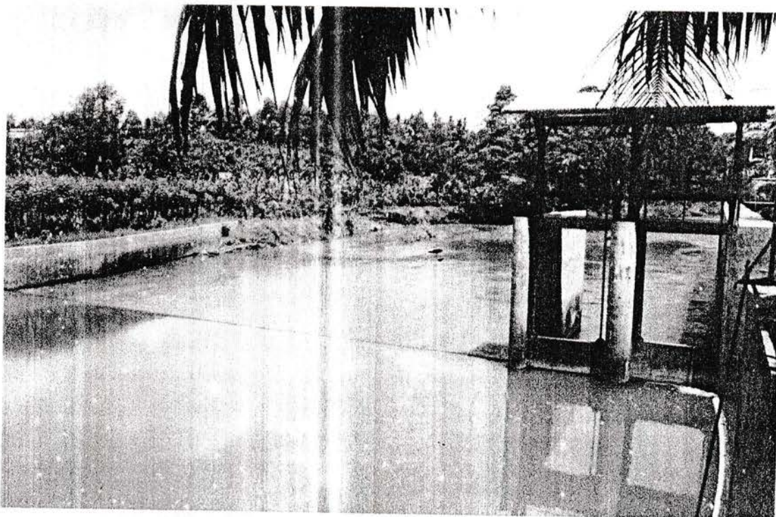
Gambar: Bendungan Instalasi Pengolahan Air Deli Tua
