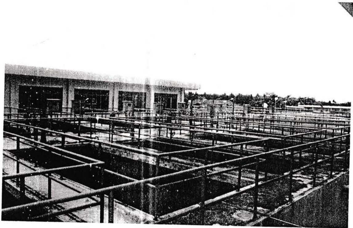
Gambar: Filter Instalasi Pengolahan Air Deli Tua
