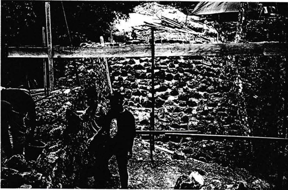
GAMBAR Pengerjaan Pondasi
