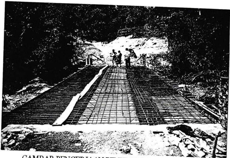
GAMBAR Pengerjaan Penulangan Plat Lantai Jembatan
