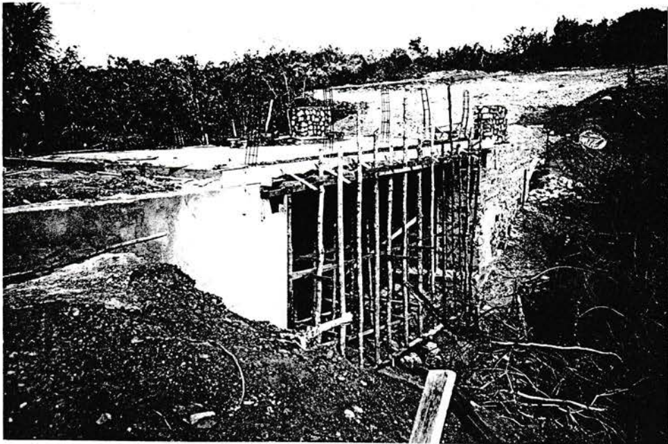
GAMBAR pengecoran plat lantai jembatan yang telah selesai
