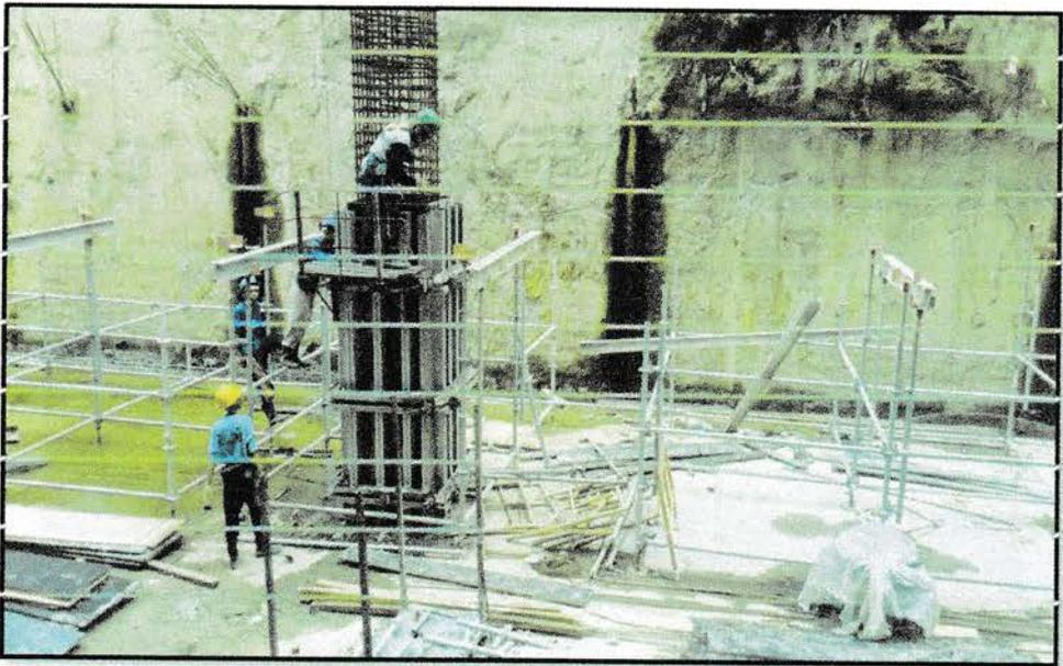
*Gambar 14. Pemasangan Bekisting Kolom*
