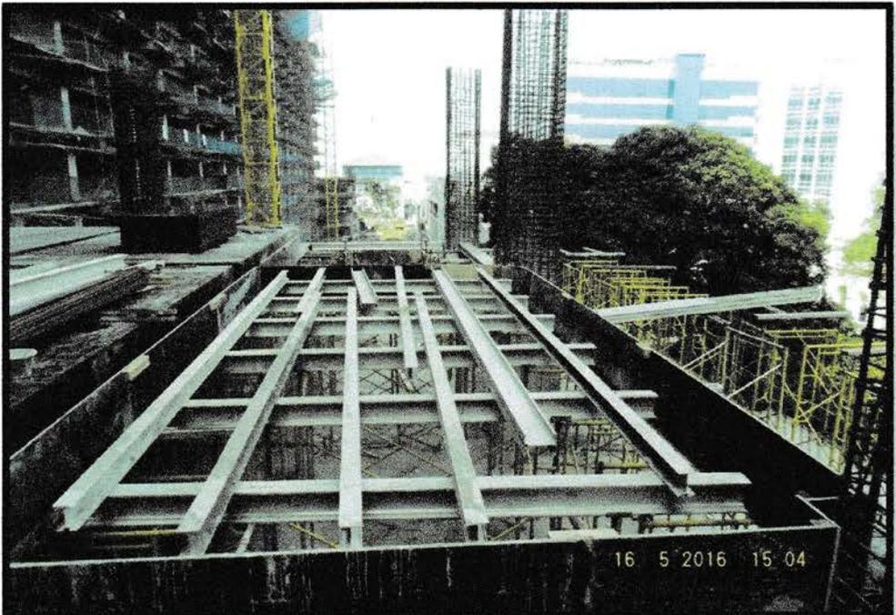
*Gambar 4 pemasangan aluma dan bekisting*
