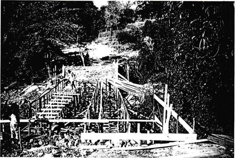
Gambar 3 Pembuatan Perancah
