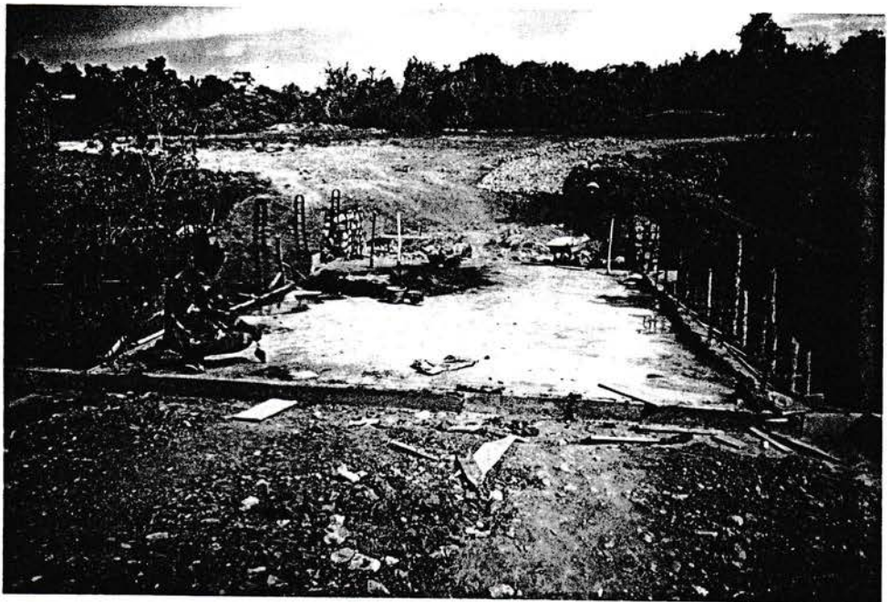
Gambar 6 Pengecoran Plat Lantai
