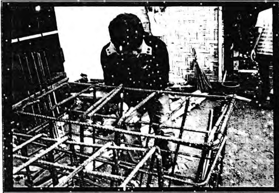
Gambar 4.5. Proses pembuatan/perakitan tulangan (pondasi)
