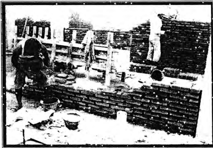
Gambar 4.8. Proses pemasangan bata
