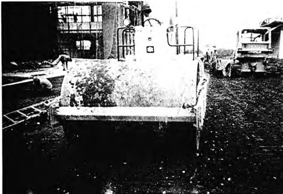
Gambar III.5. Pekerjaan Pematatan
