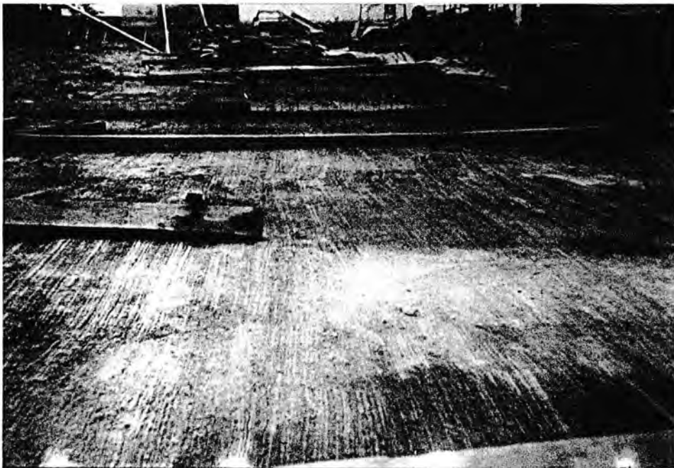
Gambar III.9. Pekerjaan Finishing (penyelesaian)
