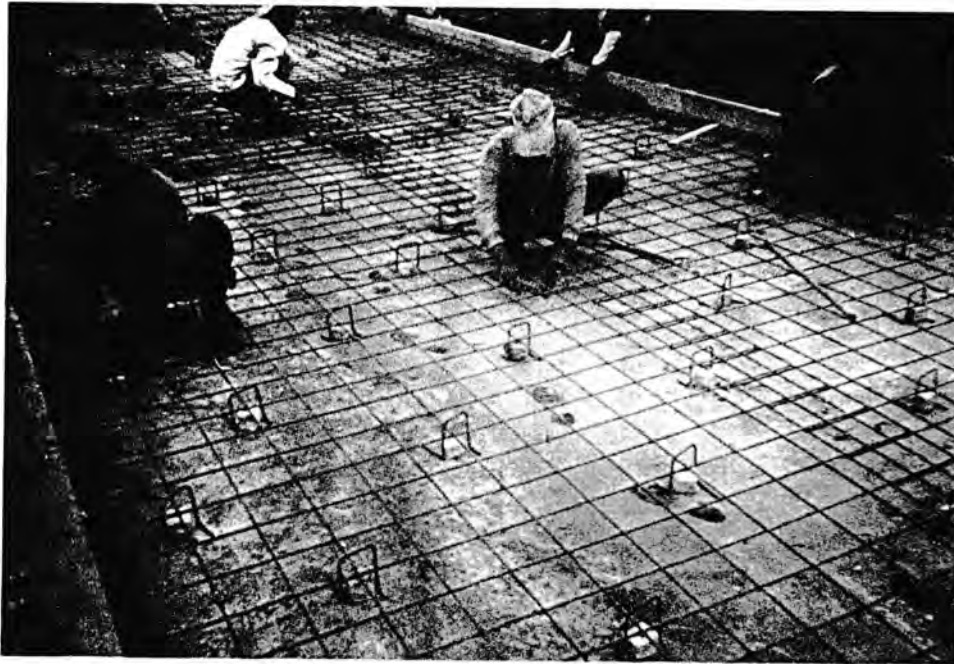
Gambar III.6. Pekerjaan bakesting dan pekerjaan pengikatan tulangan
