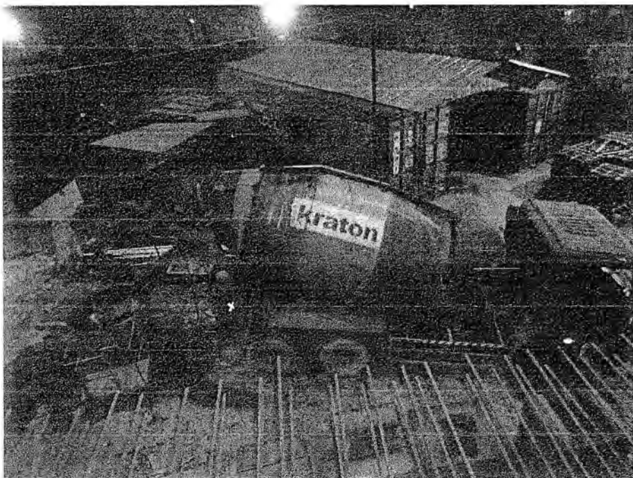
Gambar 3.2 Beton ready mix (Semen Merah Putra, Kraton)
