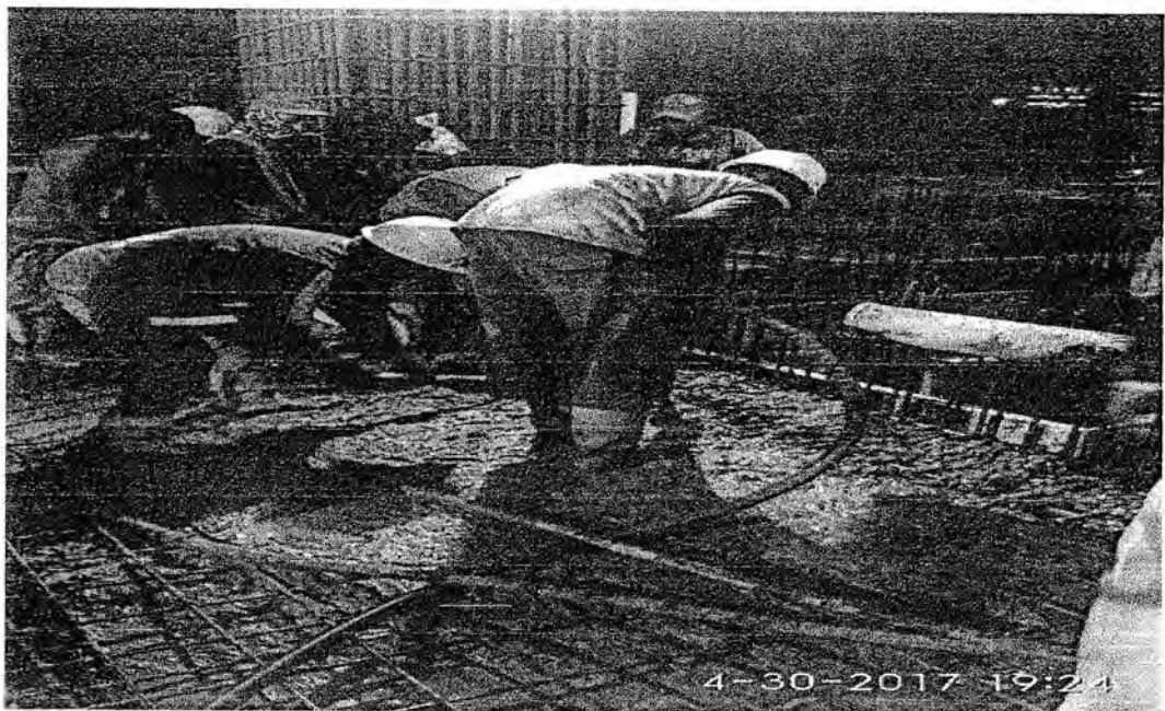
Gambar 30 : Pengecoran Plat Lantai dan Balok
