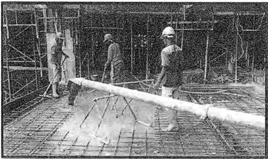
Gambar 4.4 Pengecoran Plat Lantai
