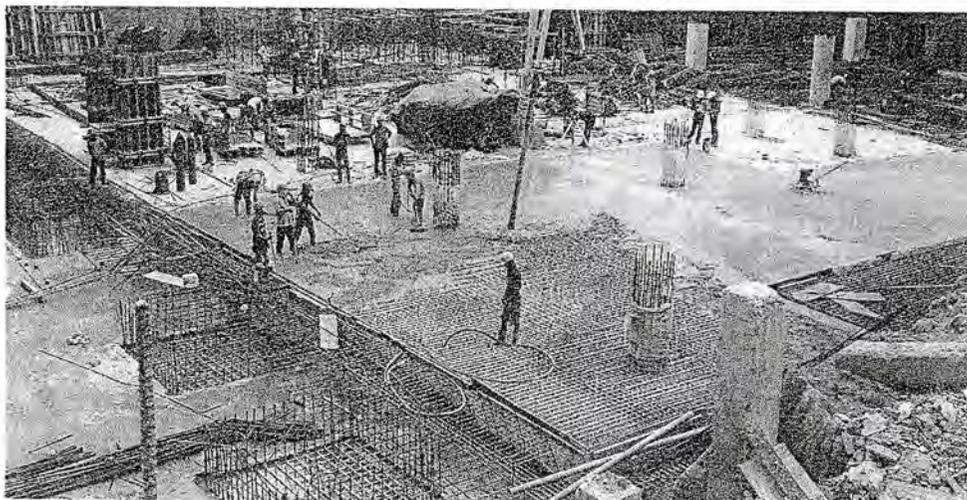
Gambar 4.2 Pengecoran Plat Lantai
