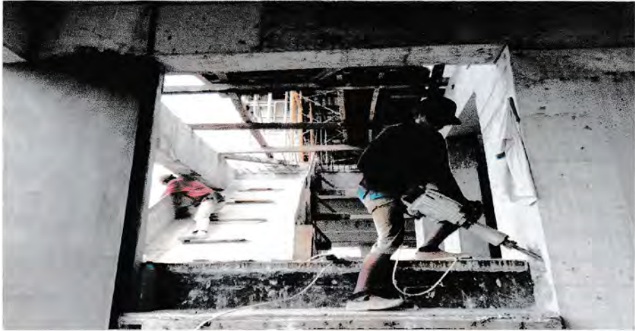
Gambar : Pekerjaan Pemasangan Bekisting & Pembersian Tangga
