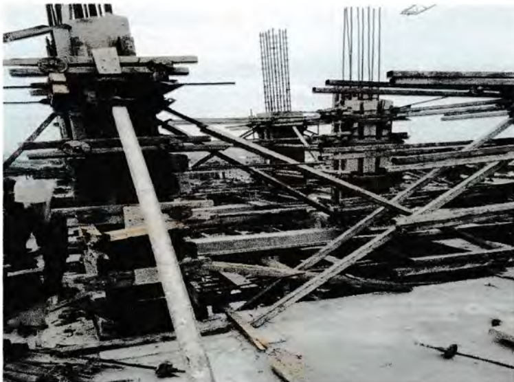
Gambar : Pekerjaan Pemasangan Bekisting, Pembesian
