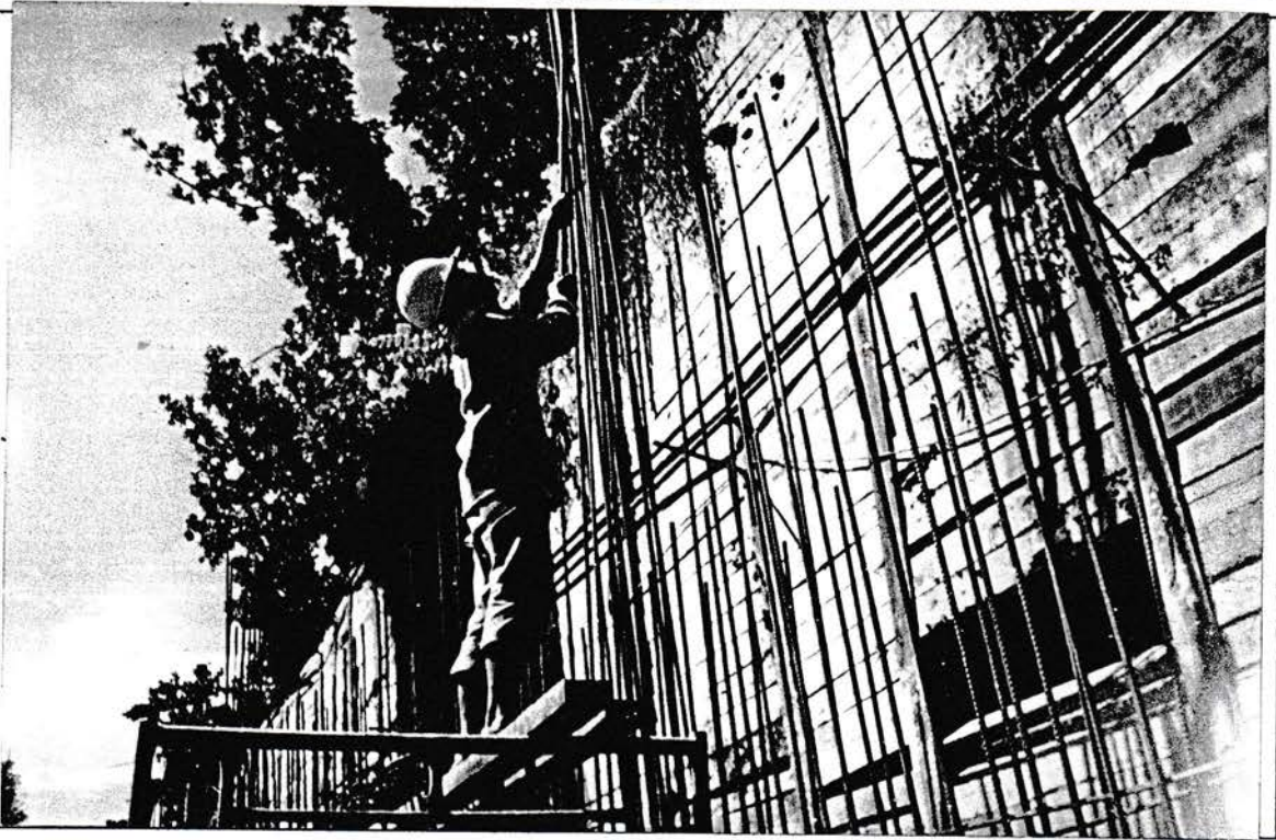
Pekerjaan Pemasangan Begel Pada Dinding Penahan Tanah
