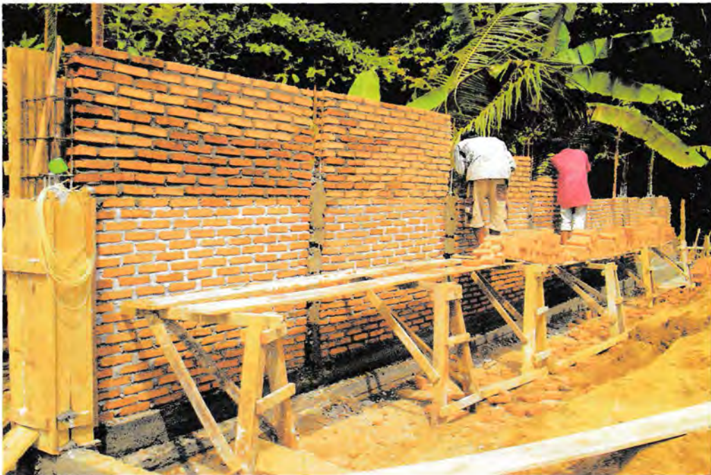
Gambar 8. Pemasangan bata pagar
