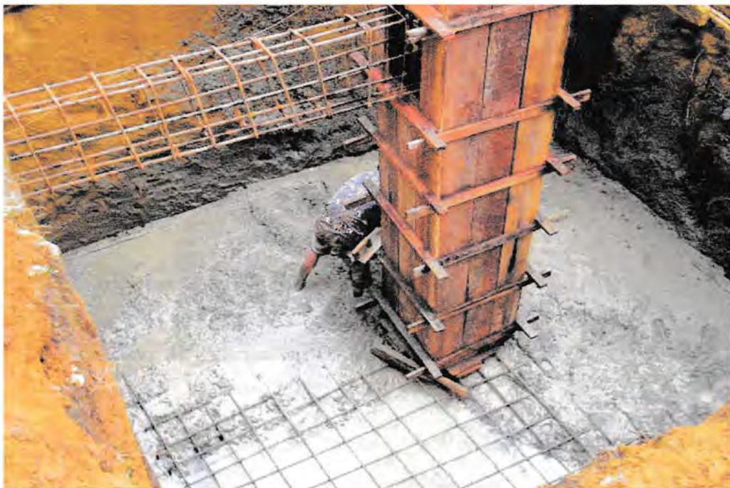
Gambar 5. Pengecoran tapak pondasi
