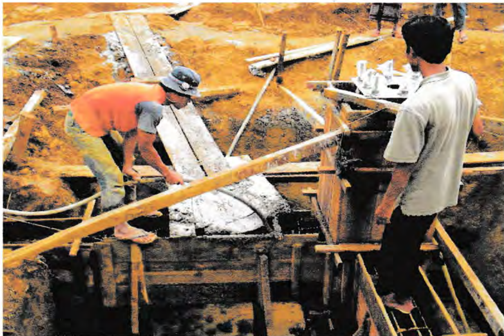
Gambar 6. Pemadatan dengan vibrator
