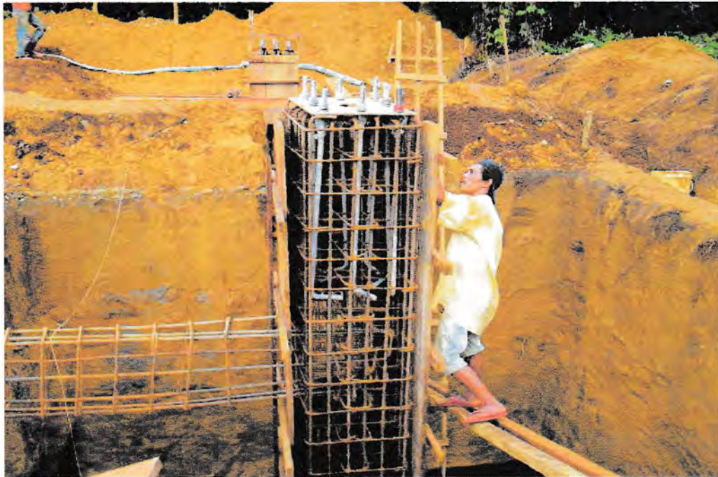
Gambar 4. Pemasangan bekisting pedestal
