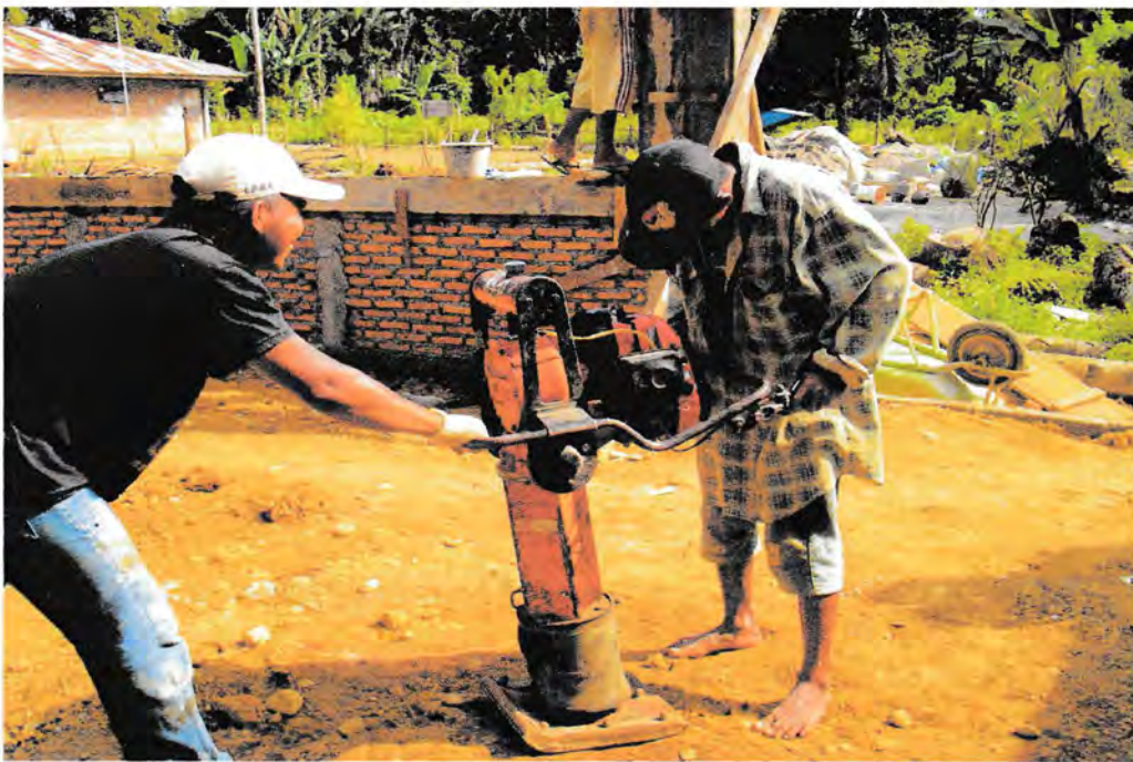
Gambar 3. Pemadatan tanah halaman
