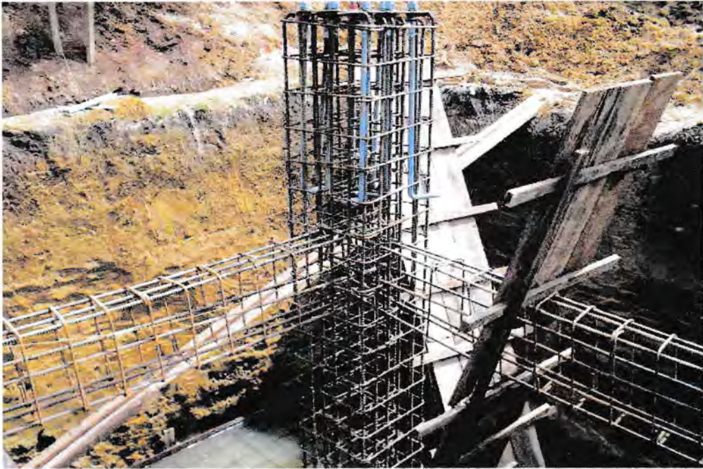
Gambar 7. Pemasangan angker bolt
