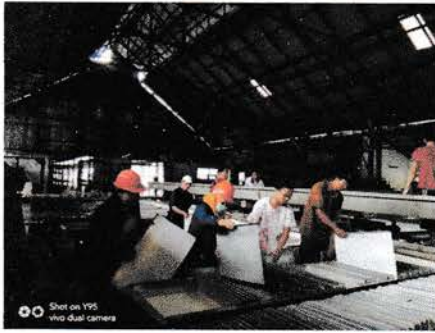
Pemasangan Plat bak Ogulasi
