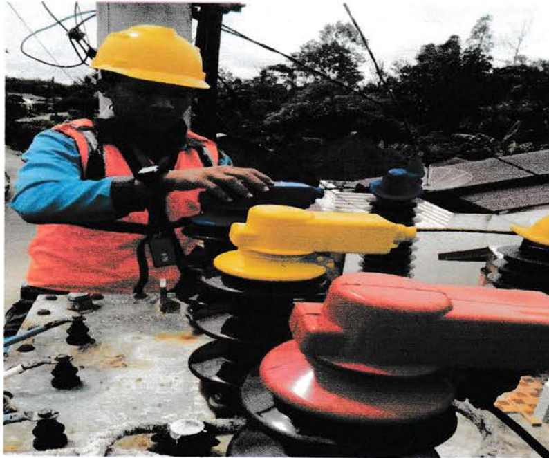
Pemeliharaan Transformator Distribusi
