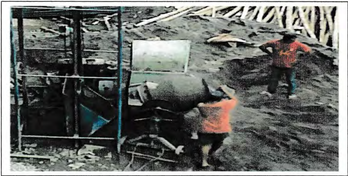
Gambar : Pengadukan Beton
