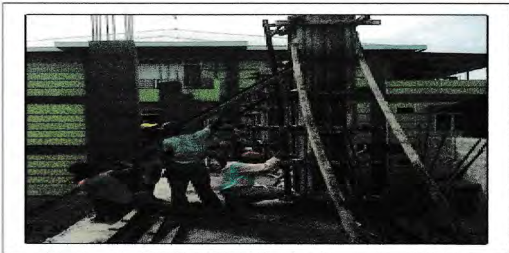
Gambar 3.0 : Pekerjaan Bekisting
