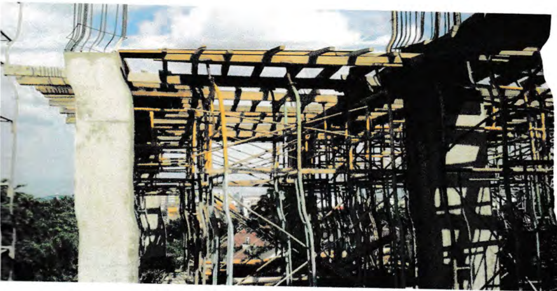
Gambar : Pemasangan Bekisting Plat Lantai
