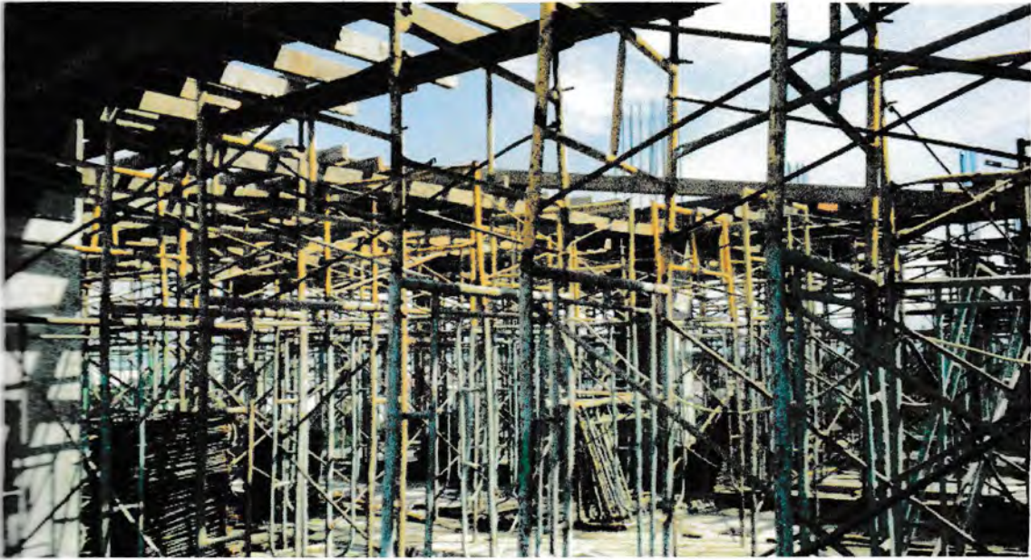
Gambar : Pemasangan Plat lantai
