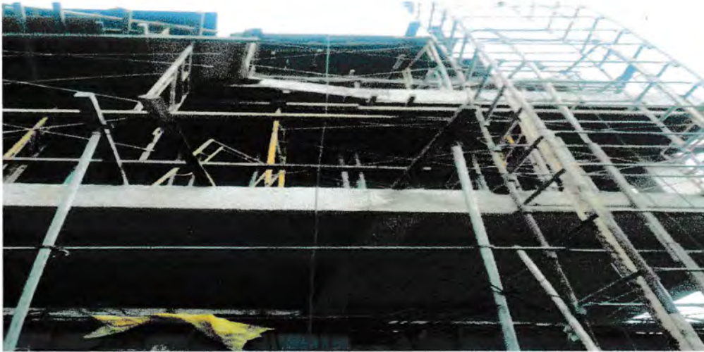
Gambar : Scaffolding untuk Molen Hidrolik
