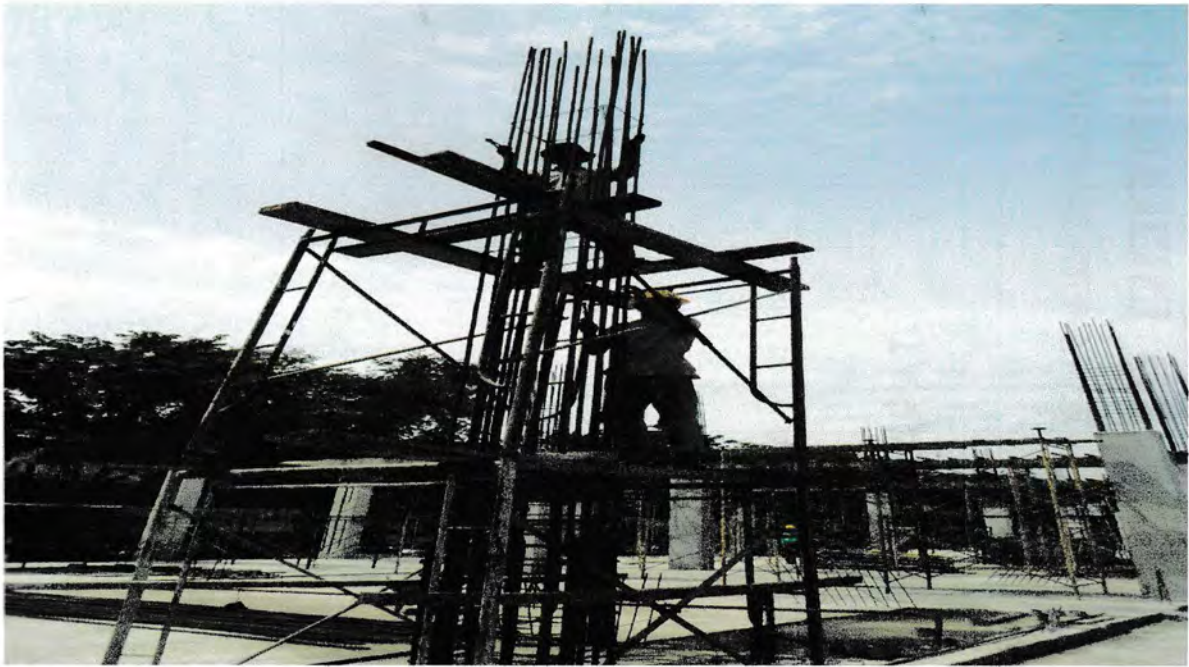
Gambar ; Pekerjaan pembesian pada kolom
