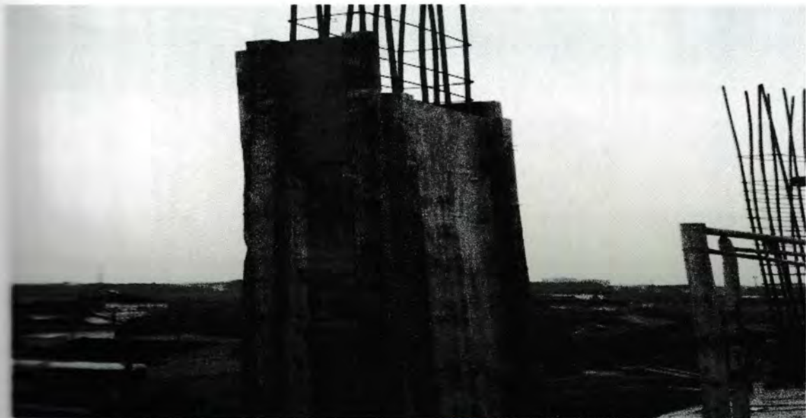
Gambar : Pemasangan Bekisting sesudah pengecoran
