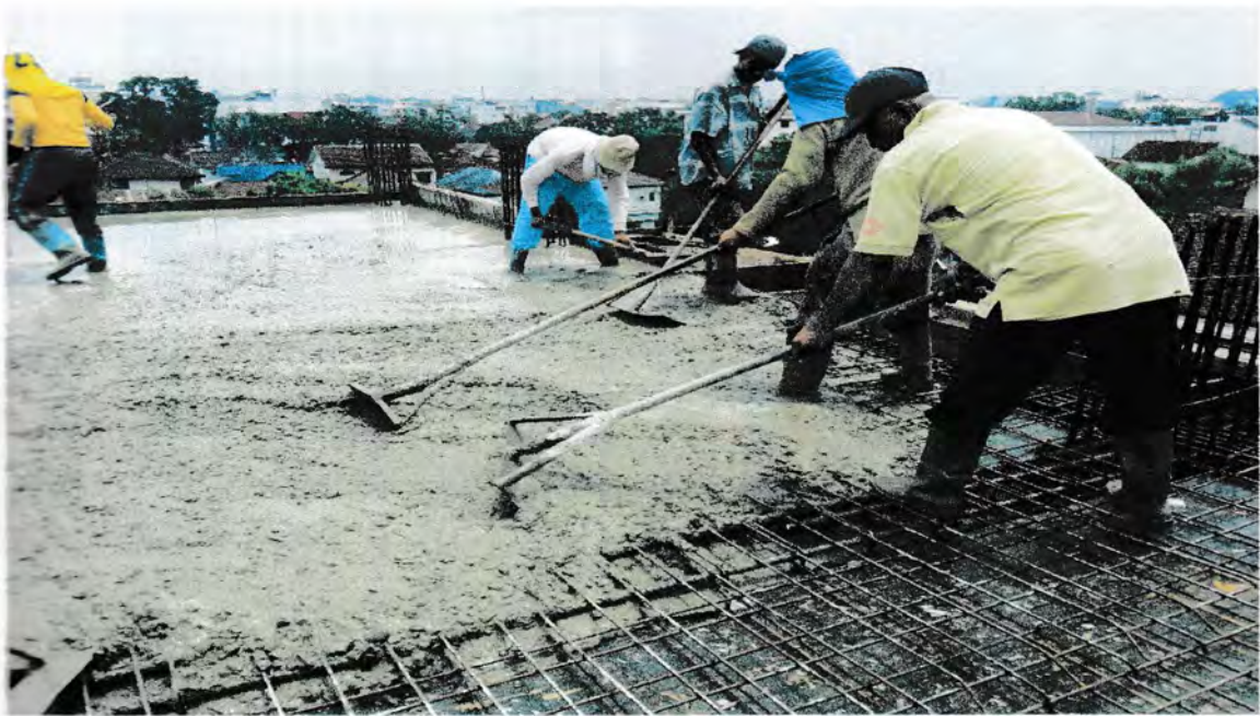
Gambar : Meratakan pengecoran pelat lantai
