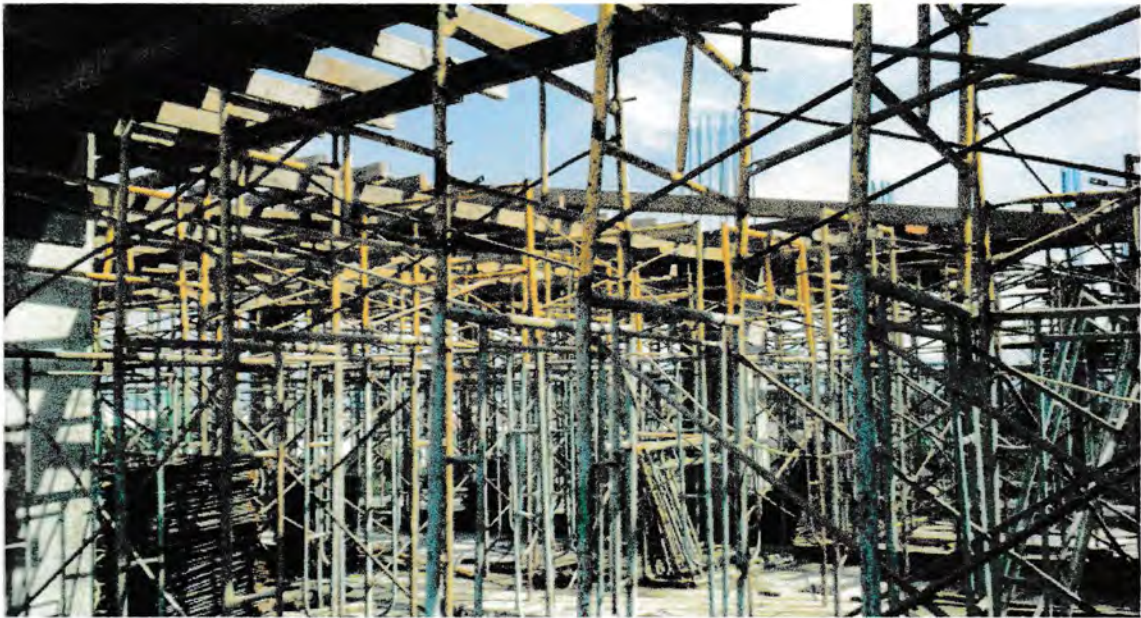
Gambar : Pemasangan Plat lantai
