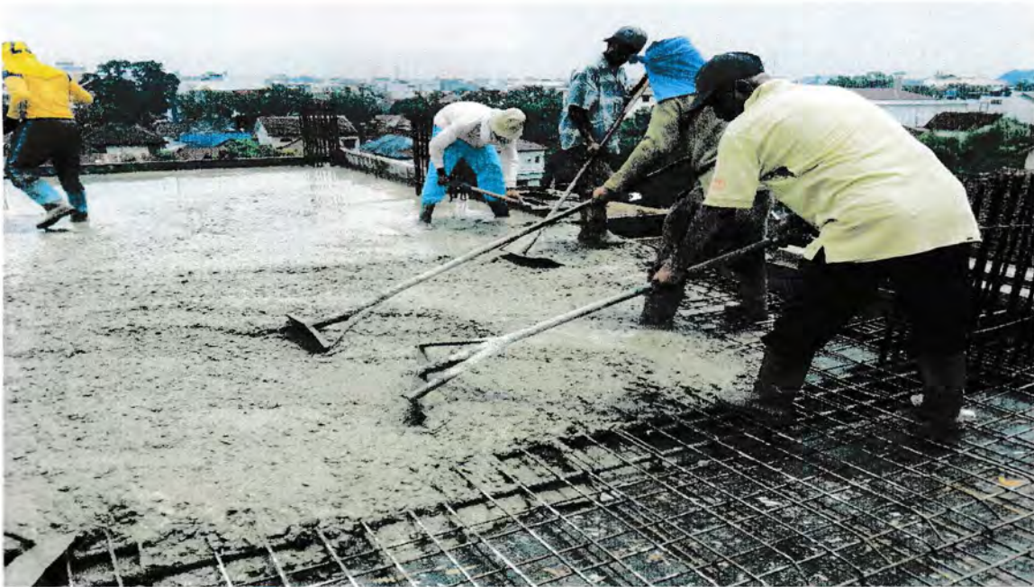
Gambar : Meratakan pengecoran pelat lantai
