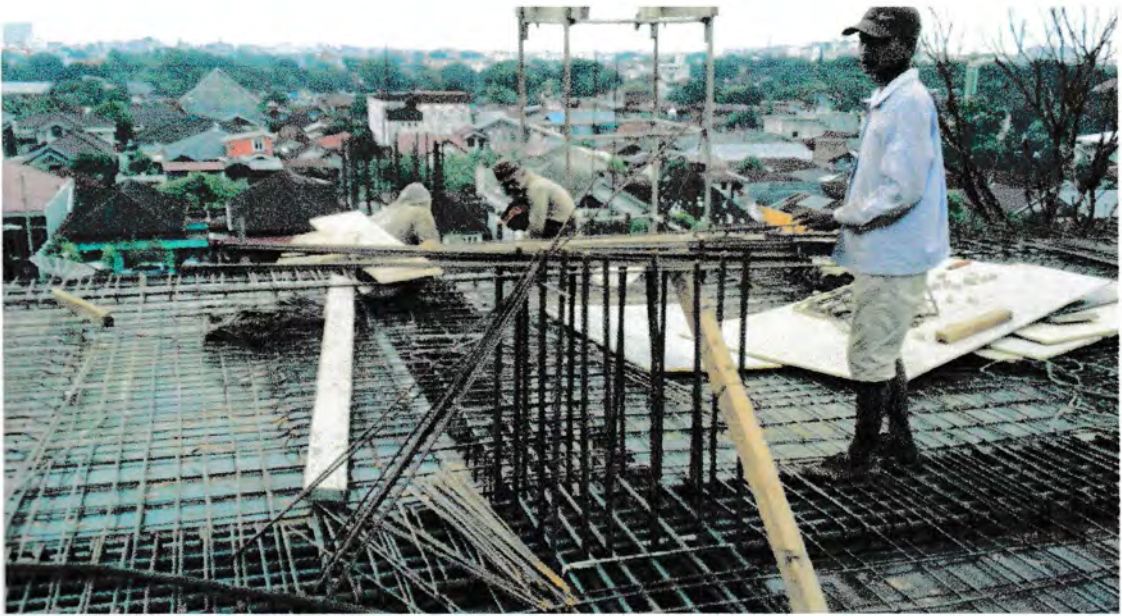
Gambar : Pemasangan dan Balok
