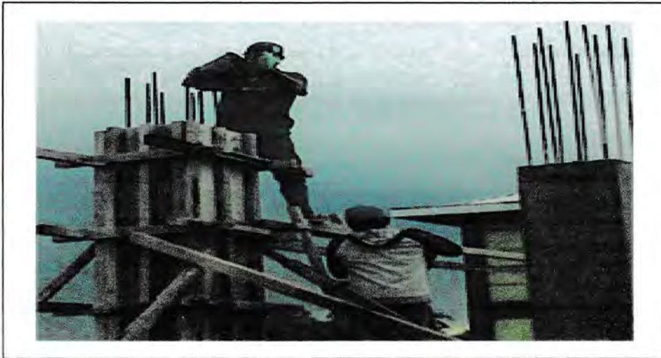
Gambar 3.1 : Penuangan Beton Ke Dalam Cetakan
