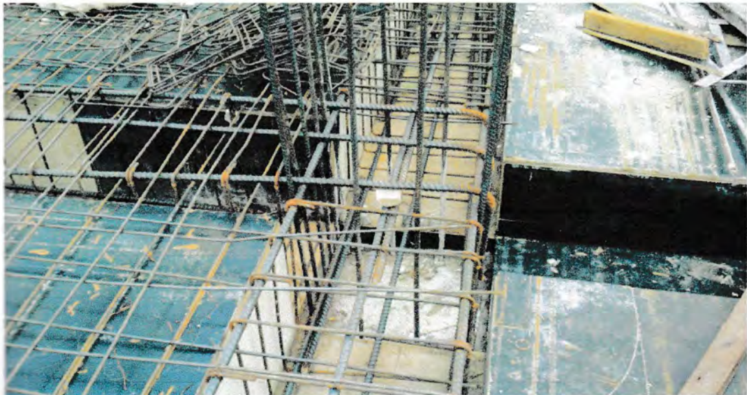
Gambar : Pembesian plat lantai dan balok
