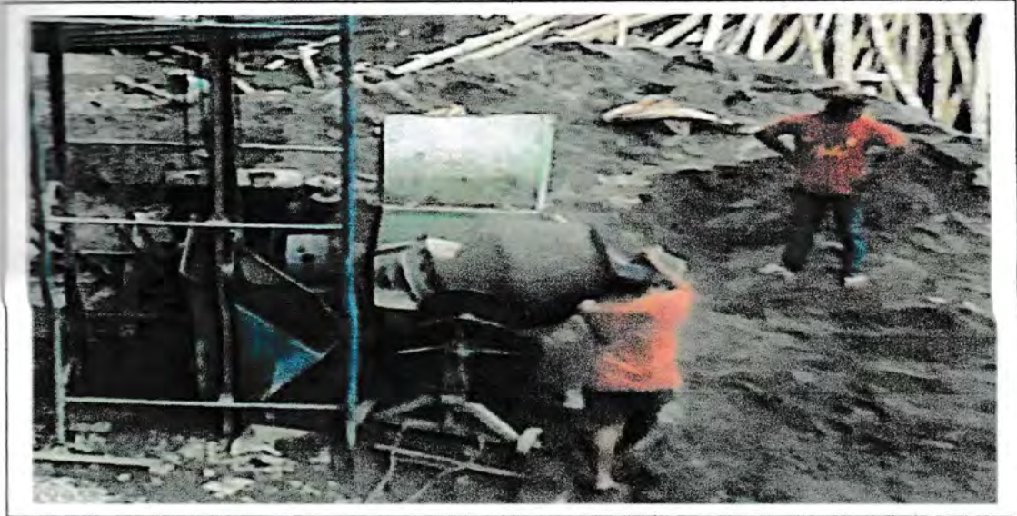
Gambar : Pengadukan Beton
