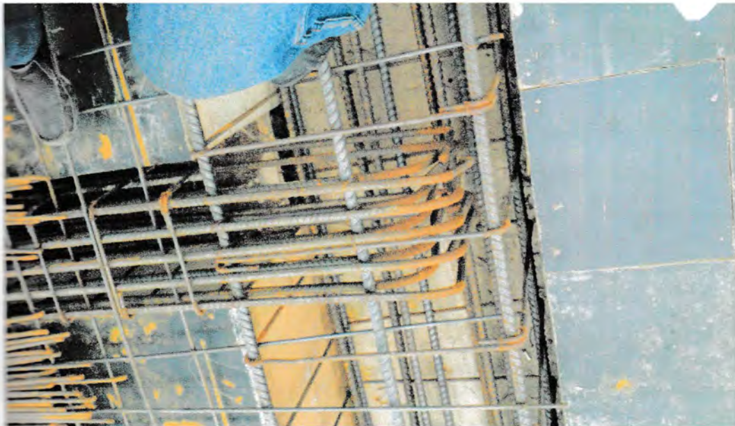
Gambar : Pemasangan Pembesian Balok
