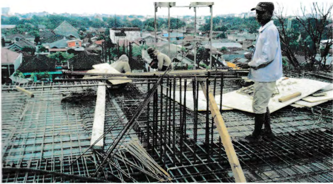
Gambar : Pembesian dan Balok
