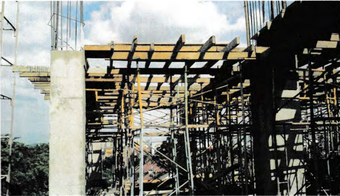
Gambar : Pemasangan Bekisting Plat Lantai
