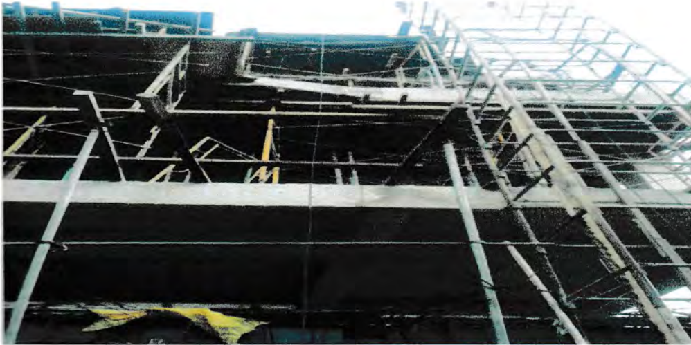
Gambar : Scaffolding untuk Molen Hidrolik
