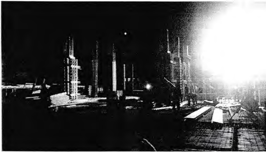
Proses Pemasangan Bekisting Dinding Peri
