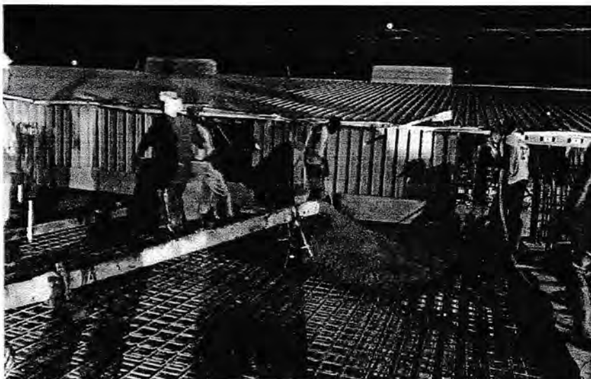
Gambar 3.9. Pekerjaan pengecoran
