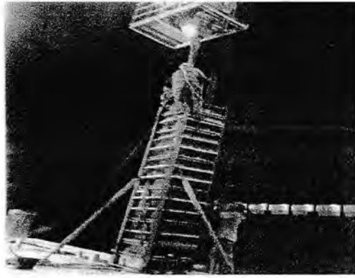
Gambar 3.1. Bekisting kolom (bekisting dinding peri)
