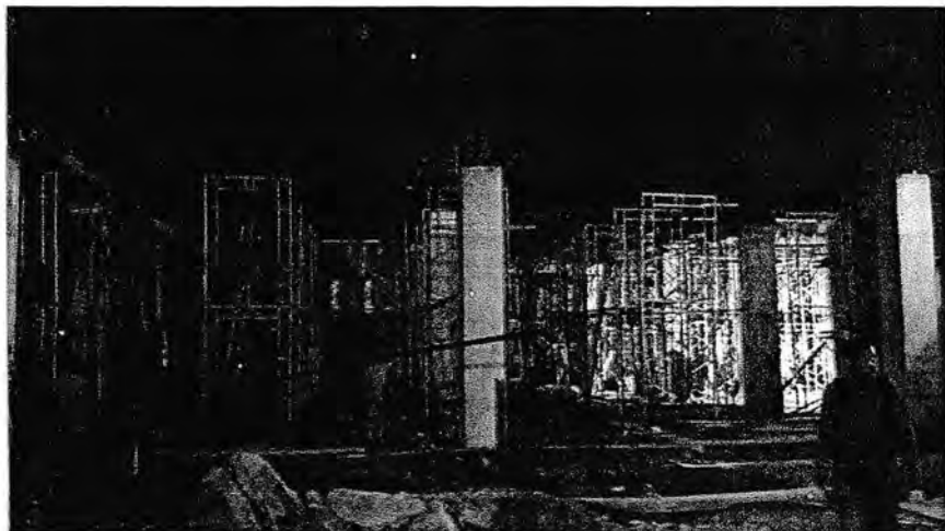
Hasil Pengecoran Kolom
