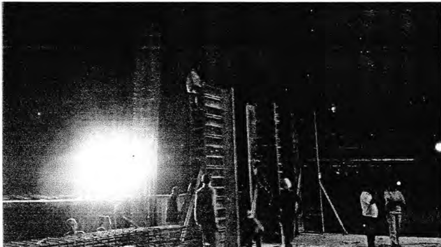
Proses Pemasangan Bekisting Dinding Peri
