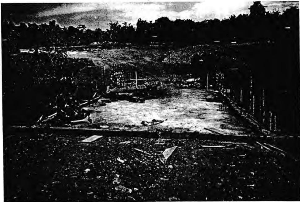
Gambar 6 Pengecoran Plat Lantai
