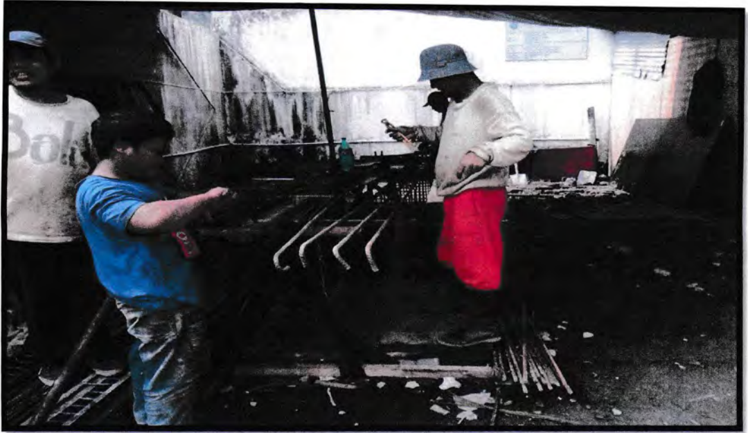
Gambar, Perakitan Besi
