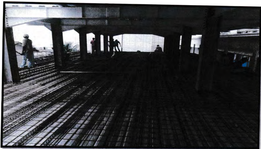
Gambar. Pemasangan Plat Wiremesh
