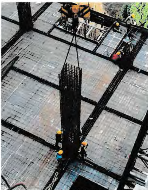
Gamabar 5.2.6 pemasangan sambuangan kolom di bantu oleh tower crane
