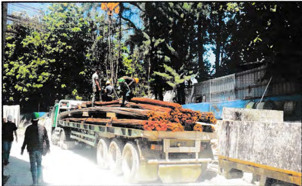
Gambar 8. Pengangkutan besi menggunakan tower crane
