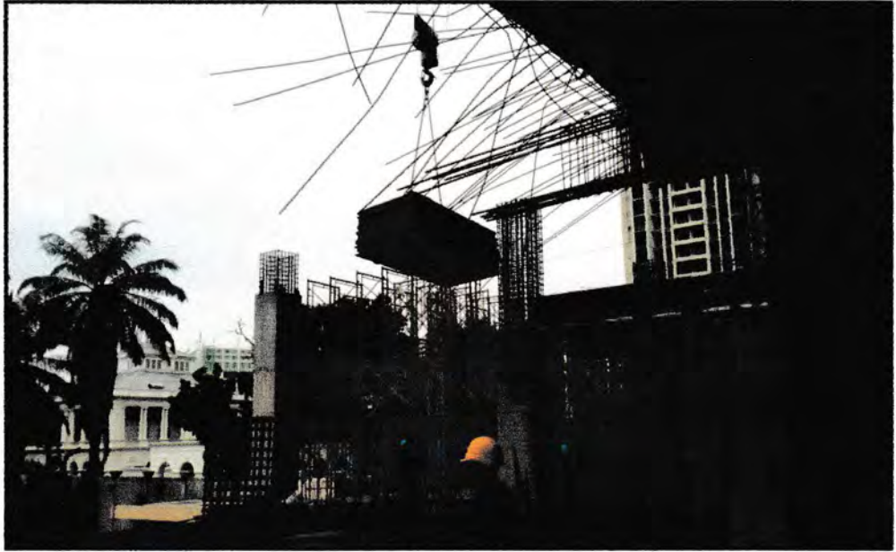
Gambar 9. Pengangkutan material bekisting menggunakan tower crane
