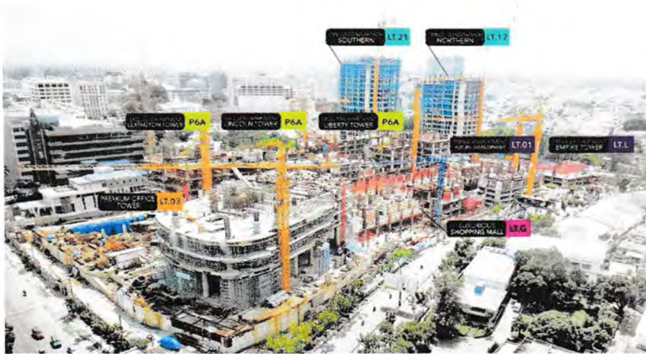
Gambar 1.2 tampak samping dari JW MARRIOT Gedung Podomoro City Deli Medan (2016)
