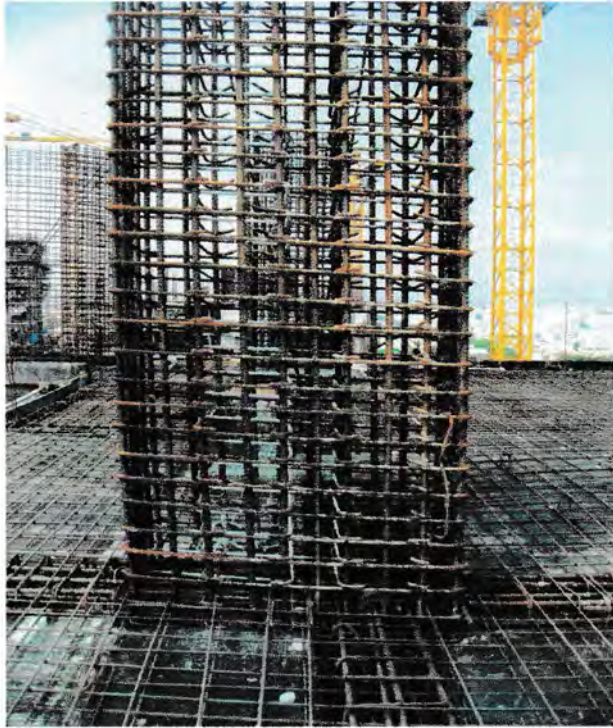
Gambar 5.2. 7 tulangan kolom yang sudah berdiri
