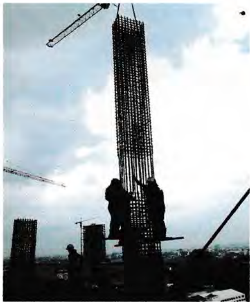
Gamabar 5.2.6 pemasangan sambuangan kolom di bantu oleh tower crane
