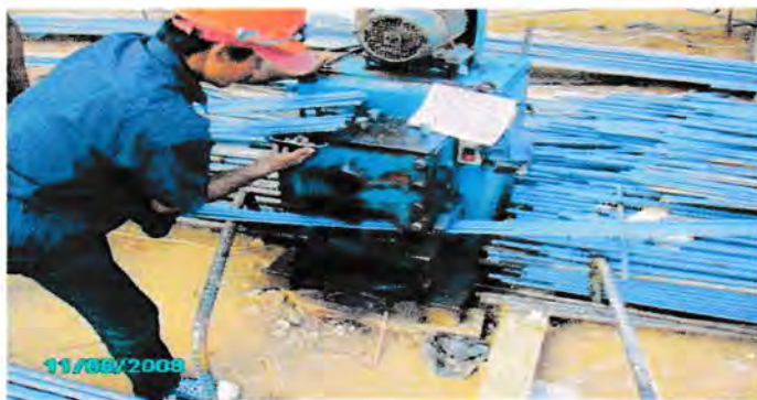
Gambar 5.2.2 Mesin Pemotong Baja (Bar Cutter)
