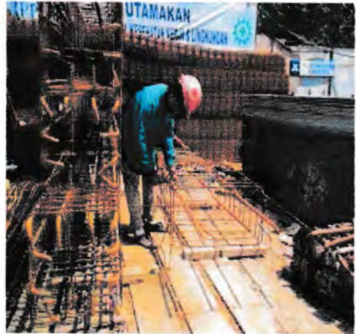
Gamabr 5.2.4 Pemasangan Cincin Kolom
