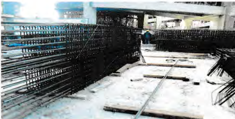
Gambar 5.2.3 Pemasangan Tulangan Kolom
