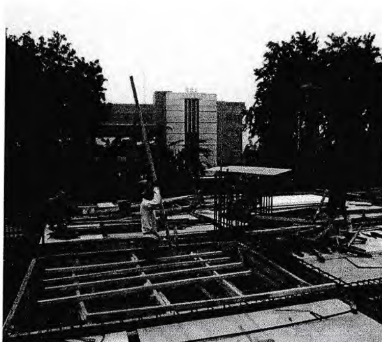
Gambar Proses Pemasangan Bekesting
