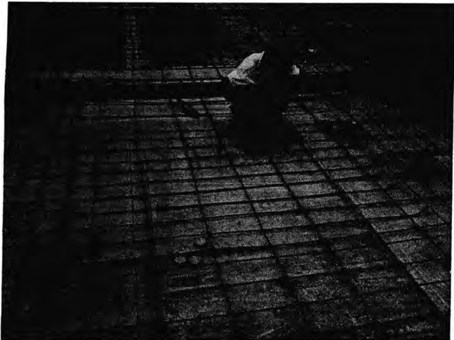
Gambar 4.16. Pekerjaan Pengikatan Tulangan Sumber : Data Lapangan 2015
