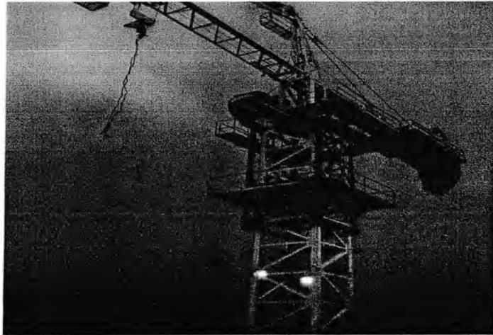
Gambar 4.9. Tower Crane Sumber : Data Lapangan 2015
