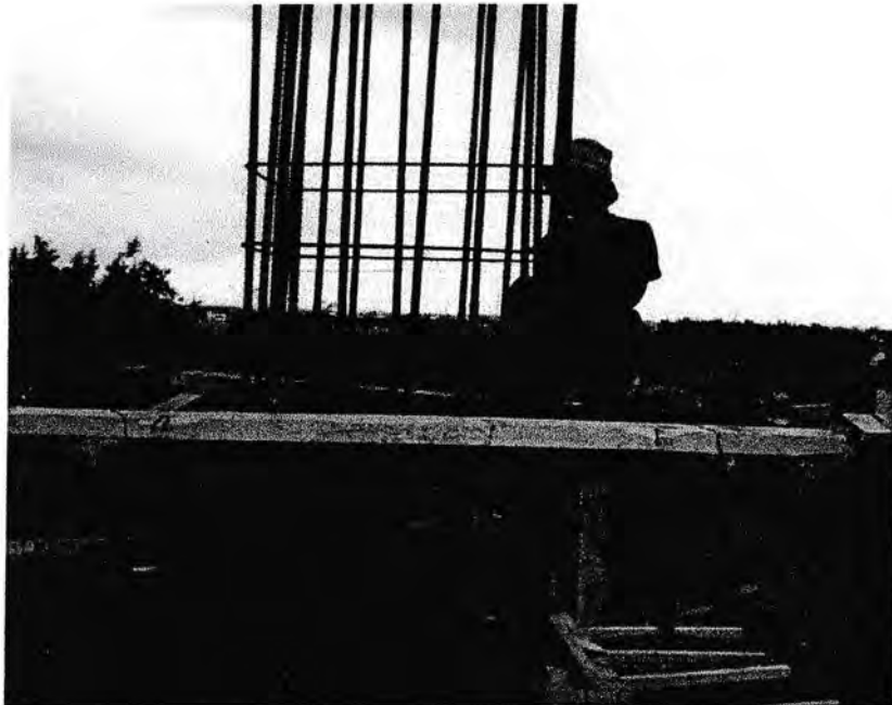
Gambar Proses Penulangan kolom Sumber : Data Lapangan 2015
