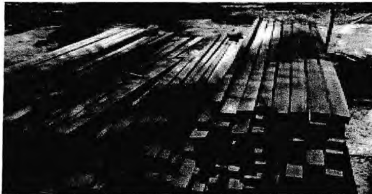
Gambar 4.6. Kayu Perancah Sumber: Data Lapangan 2015
