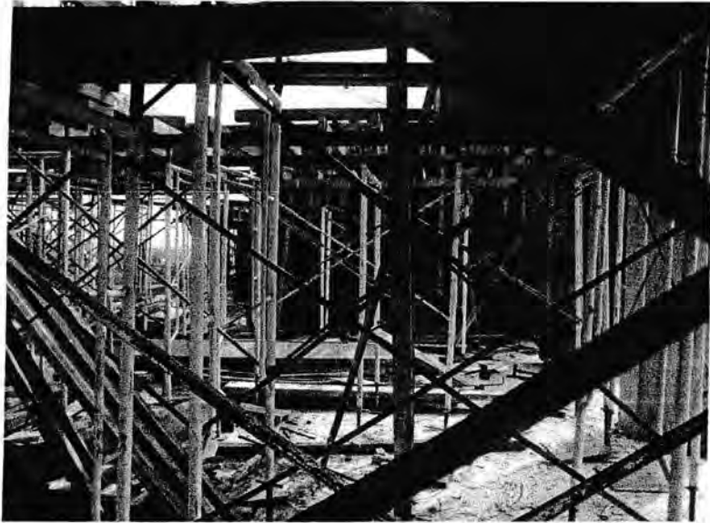
Gambar 4.11. Scaffolding Sumber : Data Lapangan 2015
