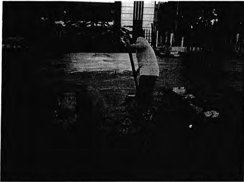
Gambar 4.19. Pekerjaan Perataan Semen Plat Lantai Sumber : Data Lapangan 2015
