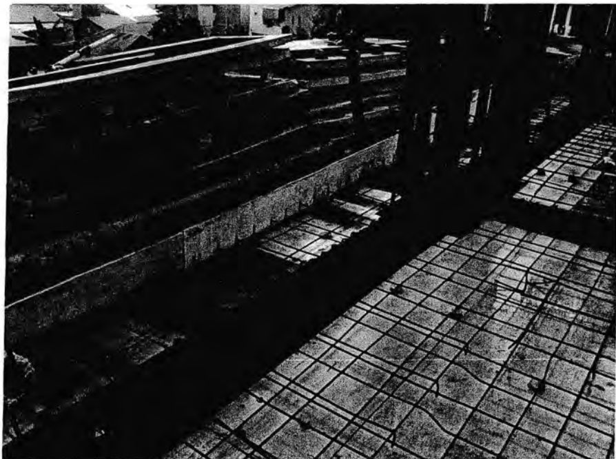
Gambar 4.17 Pekerjaan Pembesian Plat Lantai Sumber : Data Lapangan 2015
