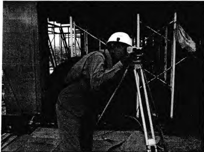
Gambar 4.13. Theodolite Sumber : Data Lapangan 2015
