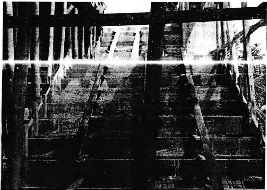
Gambar 17. Pemasangan Bakisting dan Pembesian Tangga
