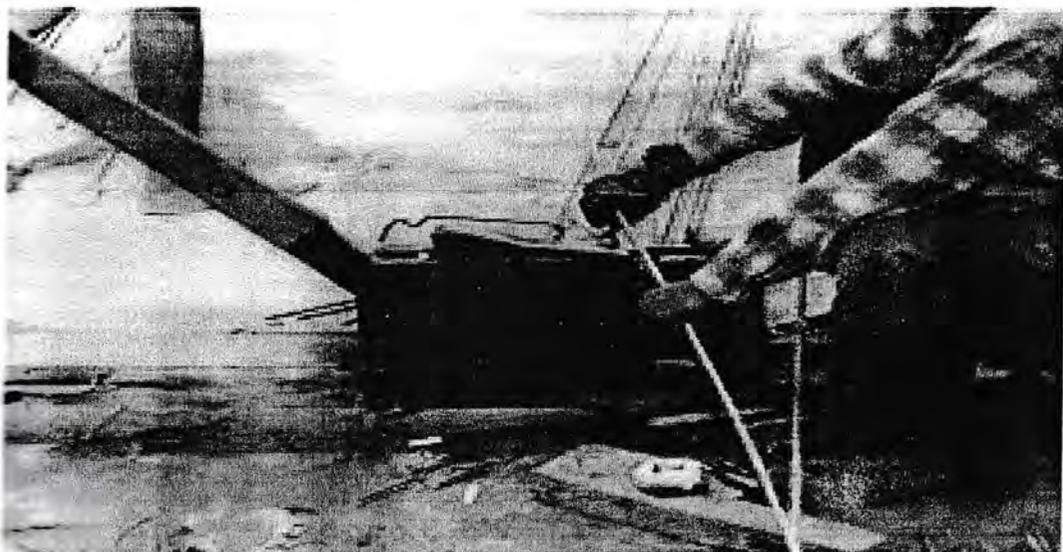
*Gambar 1. Pemotongan Besi*
