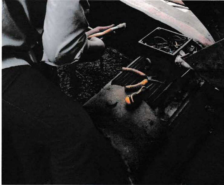
Gambar 3.2c: Pembersihan Terminal Motor Listrik Pengolahan
