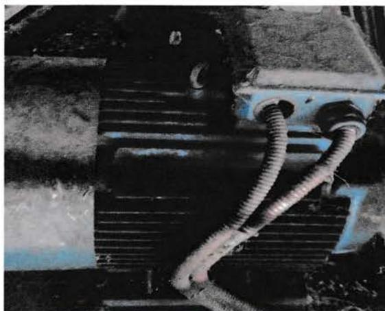
Gambar 4c: Kotoran atau Minyak Yang Menempel Pada Motor 3 Phasa
