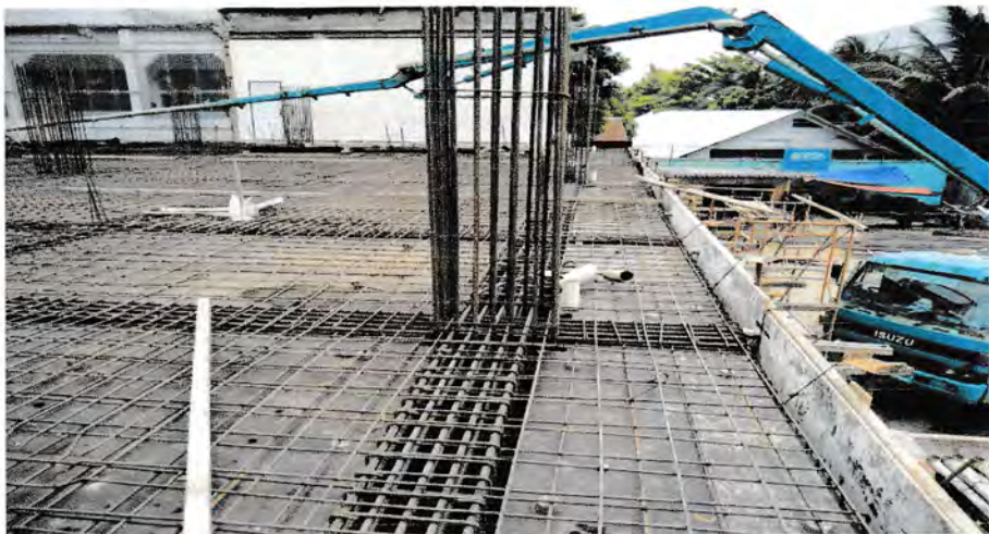
Gambar 3.19 Pengecoran Plat Lantai
