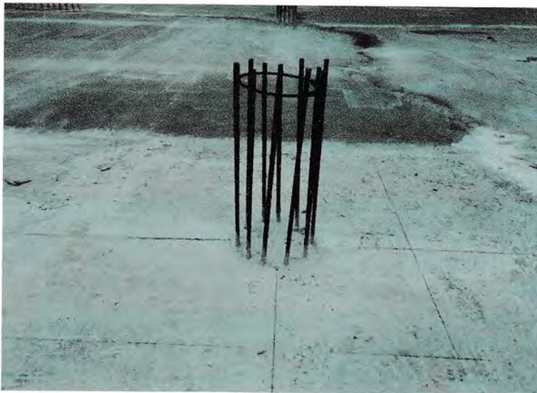
Gambar 3.2.1 : Menentukan As Kolom
