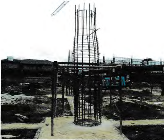
Gambar 3.2.2 : Pembesian Kolom
