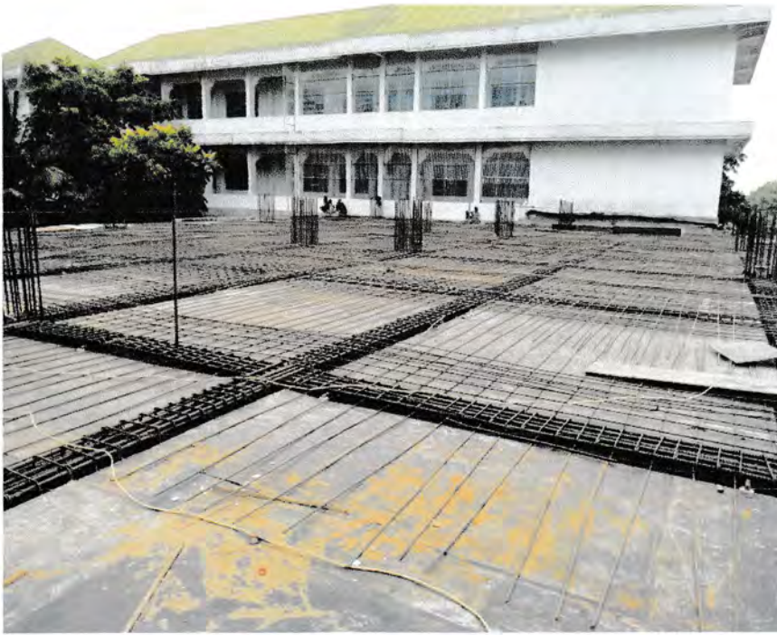
Gambar 3.17 Pembesian Plat Lantai
