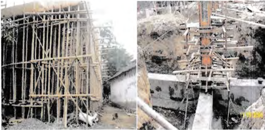
Gambar. 3.14 Bekisting Konvensional
