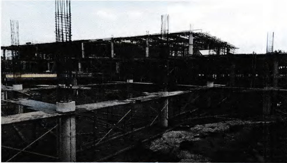
Gambar 1 : Tampak Struktur Gedung
