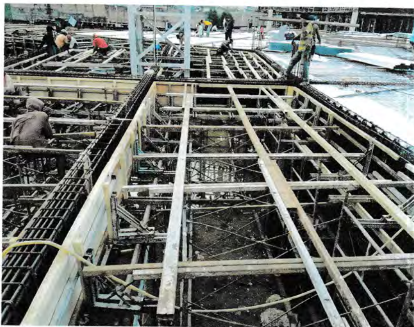
Gambar 3.2.7 : Pemasangan bekisting pelat
