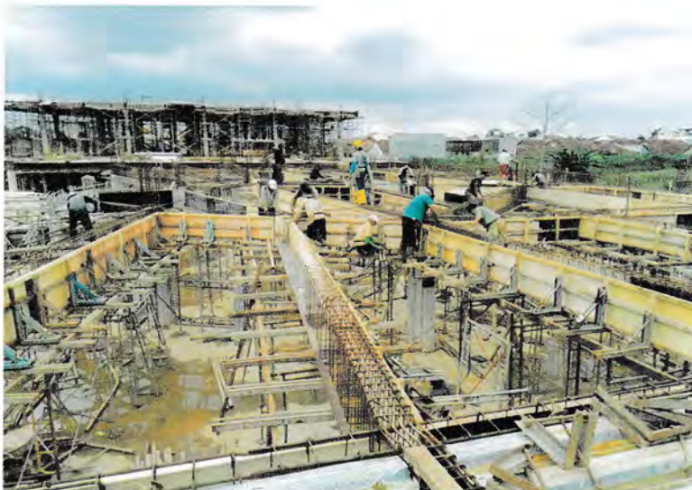
Gambar 3.2.5 : Pekerjaan bekisting balok
