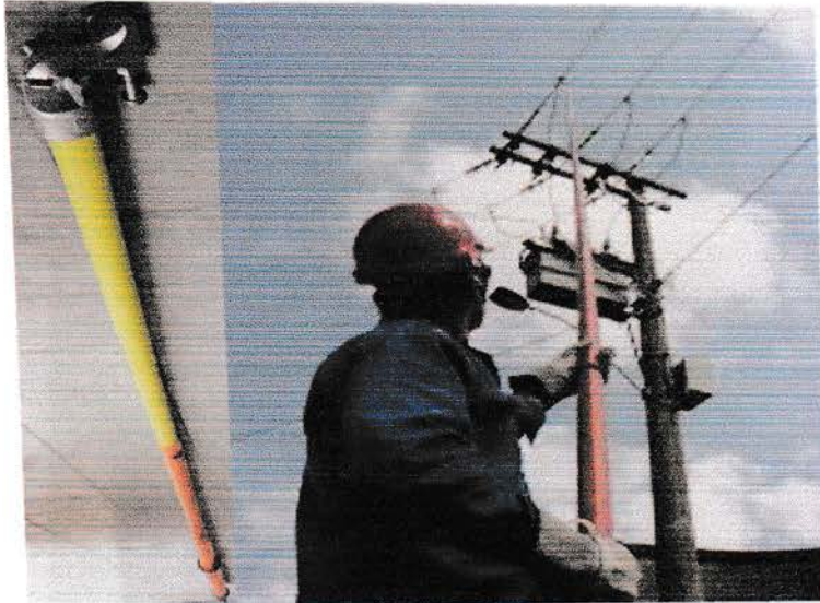
Gambar 4.4 Membuka dan Memasukan FCO (Fuse Cut Out).
