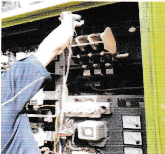
Gambar 4.5 Pasang kembali komponen-komponen PHB-TR yang belum dipasang
