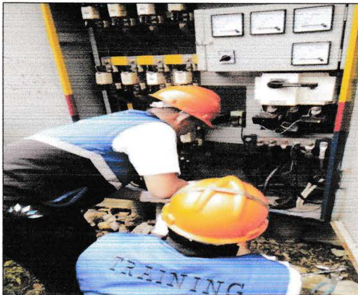
Gambar 4.2 Mengukur beban dan tegangan pada gardu.
