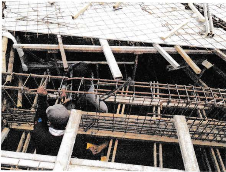
Gambar 3.2.21 Pekerjaan pembesian tulangan balok
