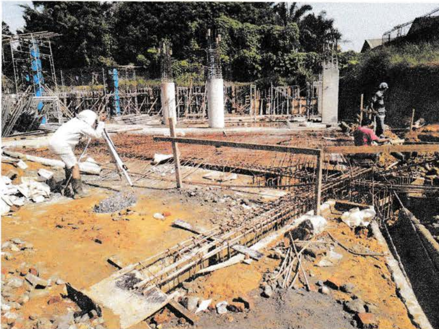
Gambar 3.2.14 Pekerjaan penentuan as balok dan kolom
