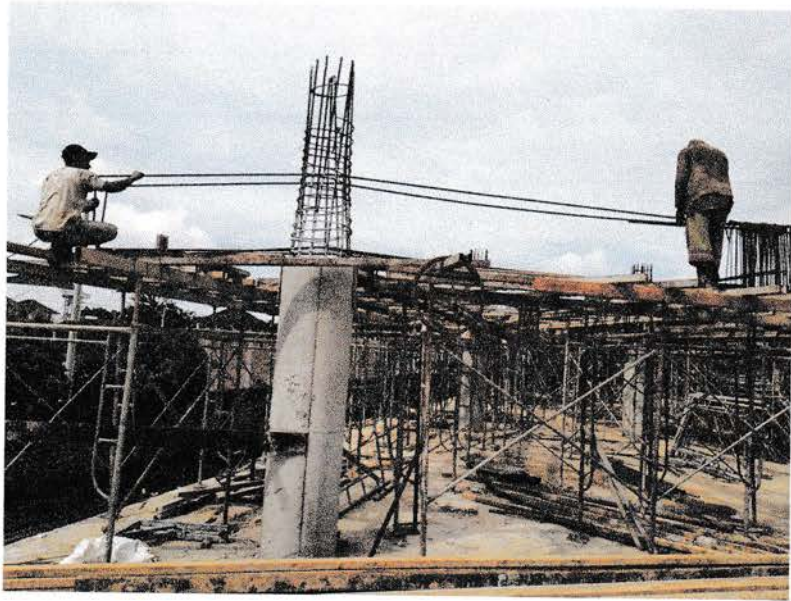
Gambar pekerjaan perakitan besi tulangan balok
