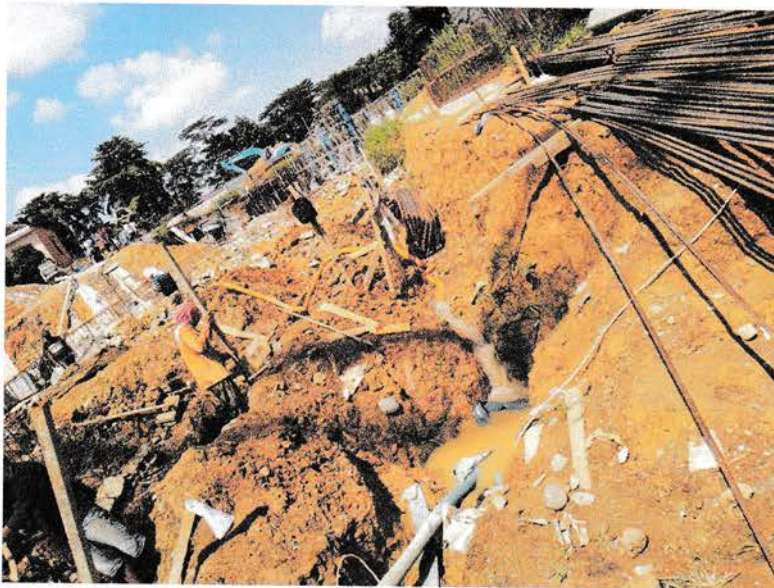
Gambar 3.2.2. Pekerjaan pengeringan air dari galian sloof
