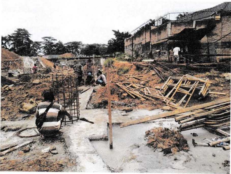
Gambar 3.2.10 Pekerjaan pemasangan tulangan kolom
