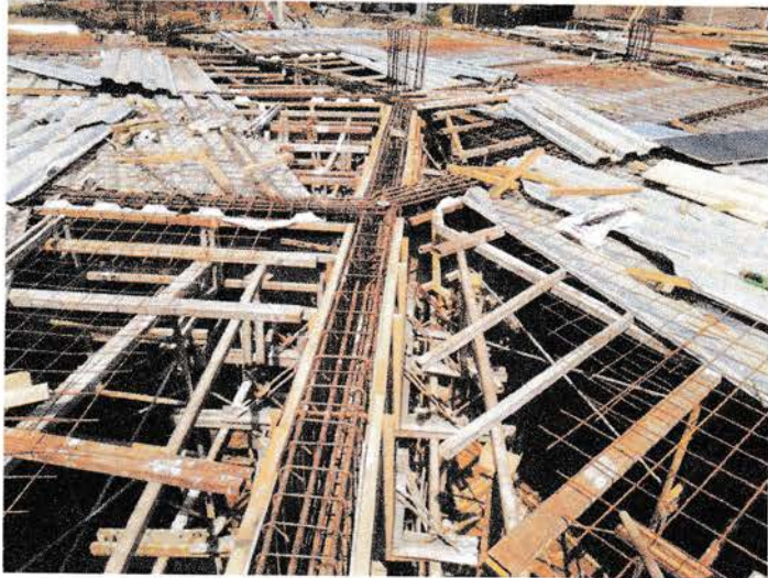
Gambar pemasangan bondex basement 2
