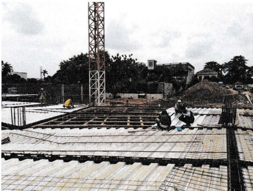
Gambar 3.2.23 Pekerjaan pemasangan bondex
