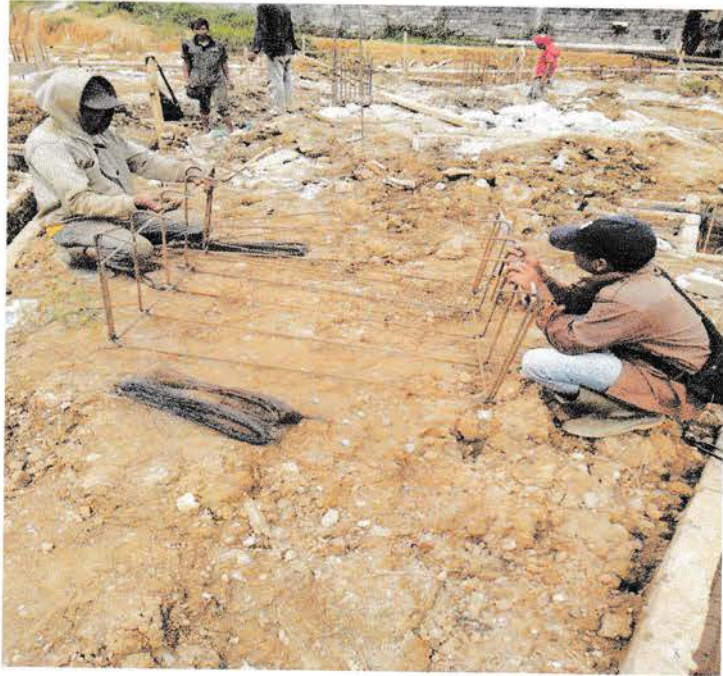
Gambar pekerjaan besi tulangan pile cap
