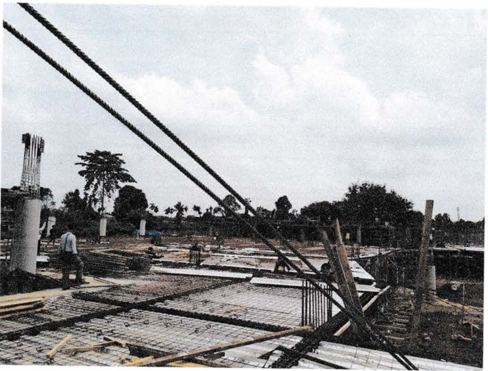
Gambar pembesian plat lantai basement 2
