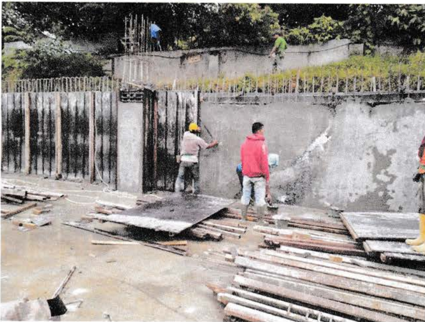
Gambar 3.2.18 Pekerjaan pembongkaran bekisting shear wall
