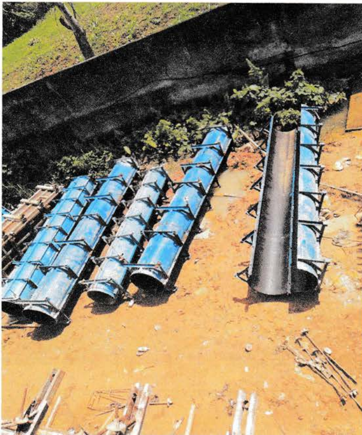
Gambar 3.1.8 Bekisting kolom
