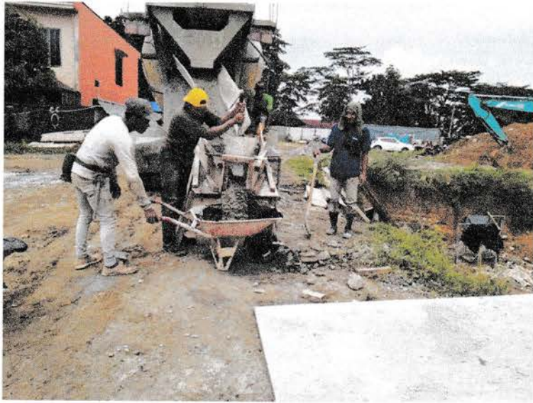
Gambar 3.2.12b Penuangan beton dari mixer ke angkong
