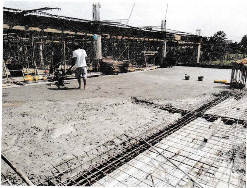
Gambar pekerjaan pepadatan permukaan lantai dengan mesin trowel
