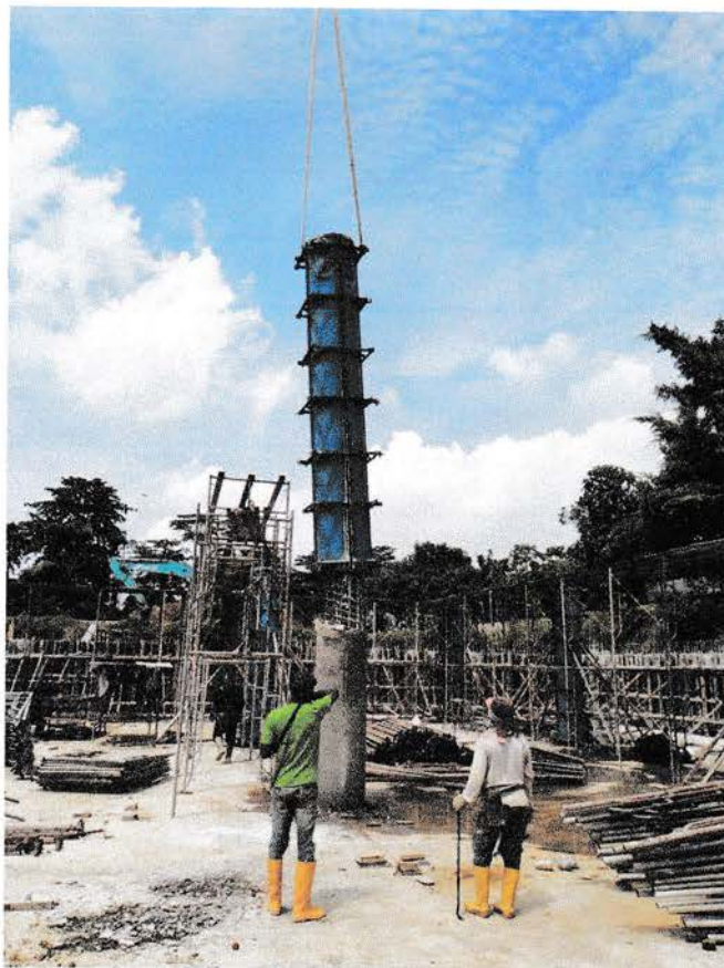
Gambar pemasangan bekisting kolom basement 2
