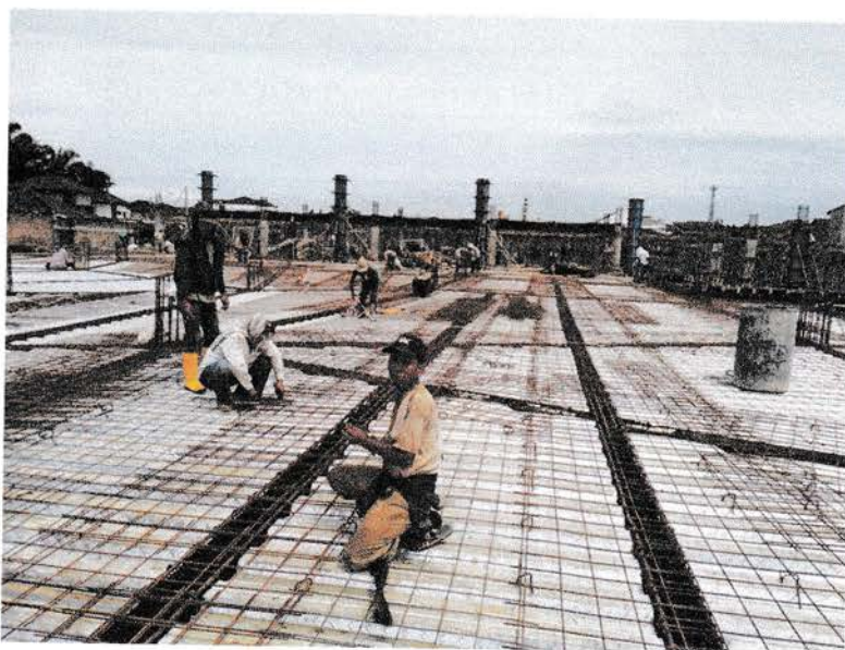
Gambar 3.2.24 Pekerjaan pemasangan tulangan plat lantai
