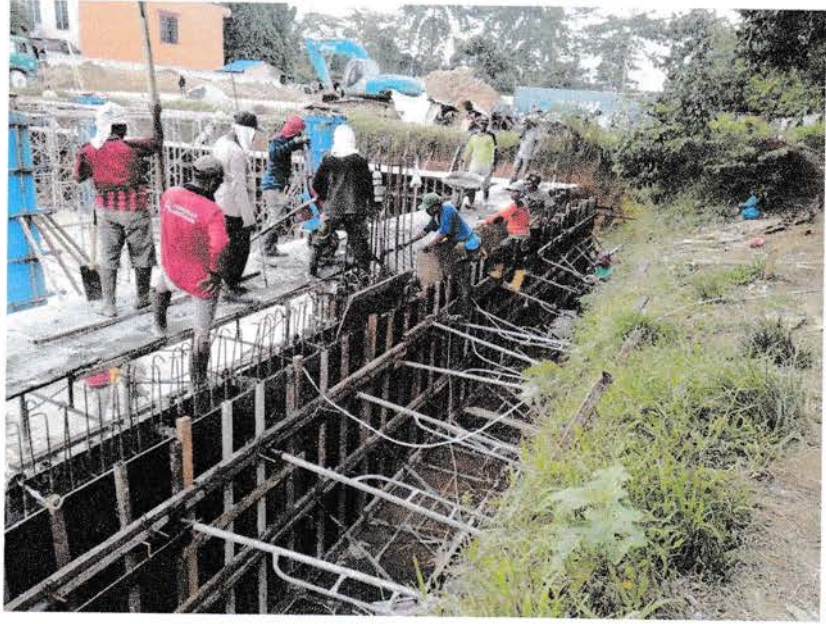
Gambar pekerjaan pengecoran shear wall
