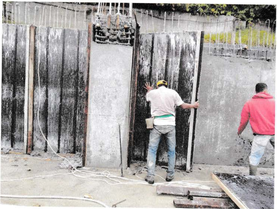
Gambar pembongkaran bekisting shear wall
