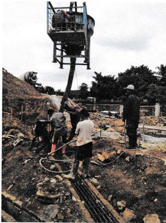
Gambar 3.2.8 Pengecoran areal sloof dengan bucket cor
