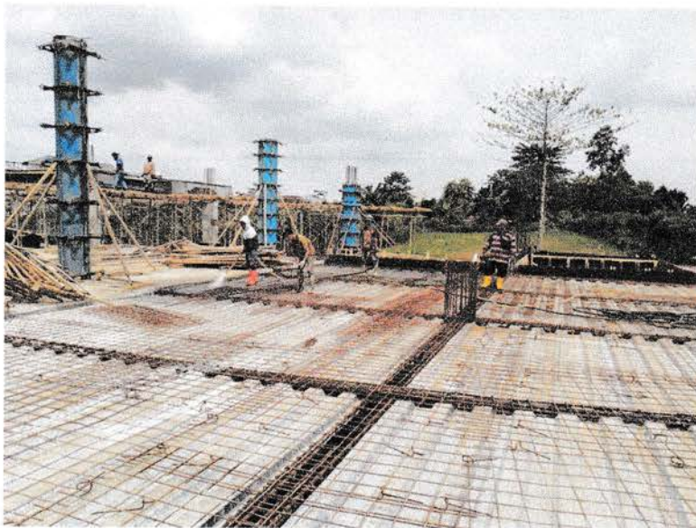
Gambar Pembersihan plat lantai dan balok basement 2
