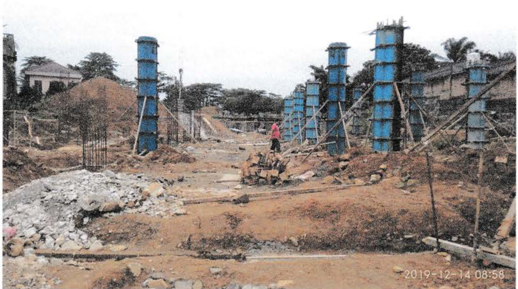
Gambar 3.2.11 Pekerjaan bekisting kolom
