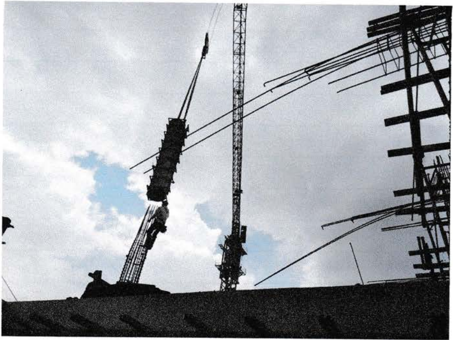
Gambar pemasangan bekisting kolom basement 2
