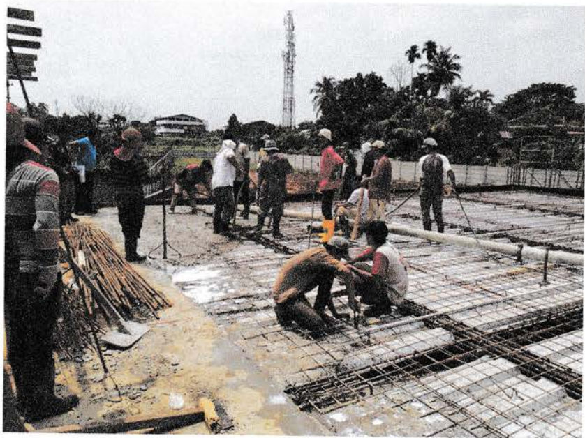
Gambar pekerjaan pengecoran lantai basement 2
