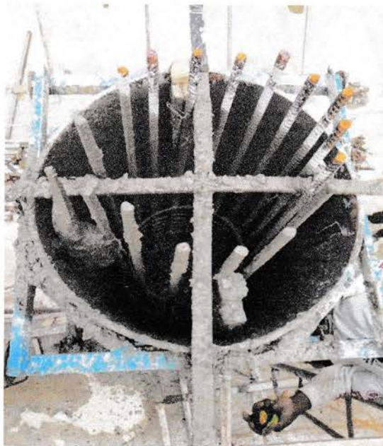
Gambar 3.2.12c Bekisting kolom yang sudah berisi beton segar
