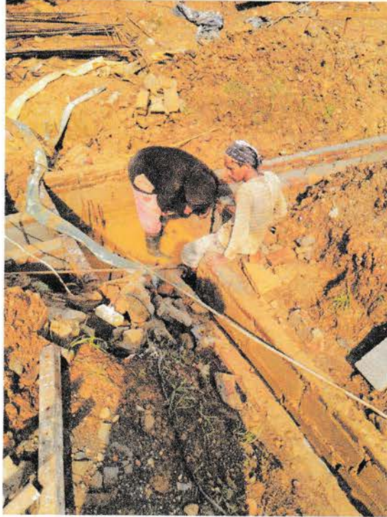
Gambar 3.2.3 Pekerjaan bekisting pasangan batu pada sloof
