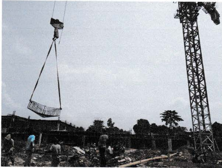
Gamabar 3.2.6b Mobilisasi pile cap dengan tower crane
