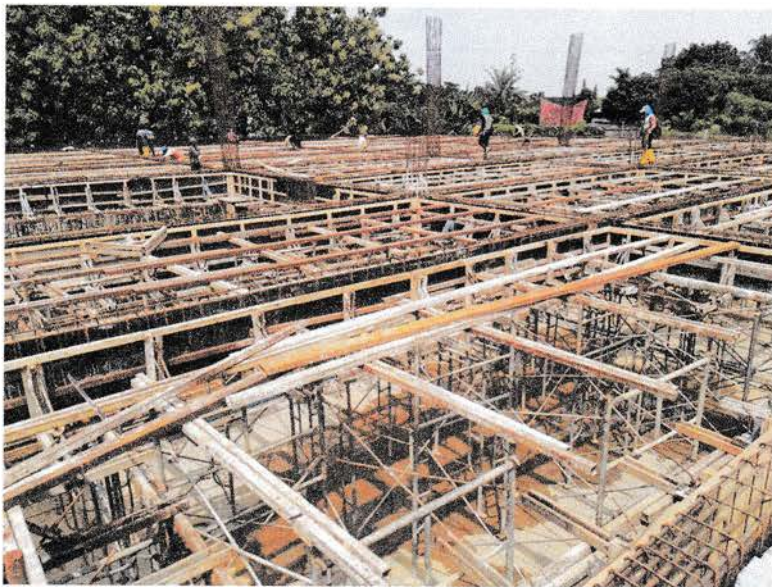
Gambar 3.2.22 Pekerjaan bekisting plat lantai
