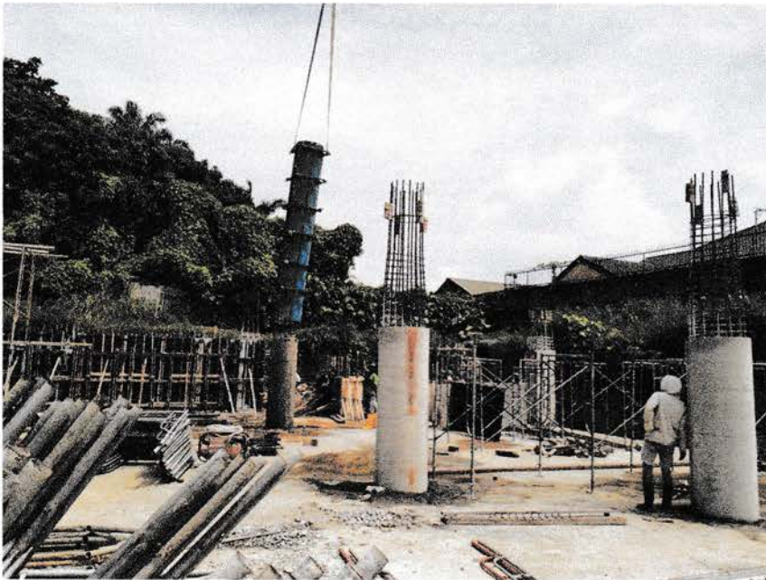
Gambar 3.2.13 Pembongkaran bekisting kolom dengan alat tower crane
