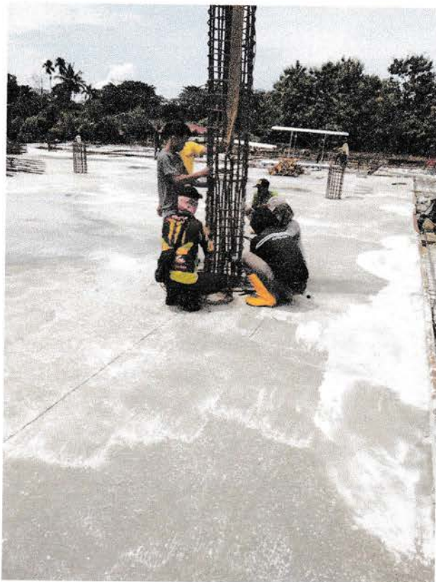
Gambar pekerjaan penyambungan besi tulangan kolom
