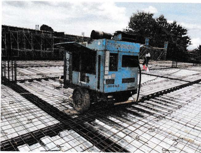
Gambar 3.2.25 Pembersihan balok dan plat lantai
