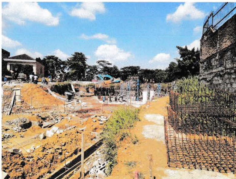
Gambar 3.2.6 Besi tulangan pile cap di pabrikasi pembesian
