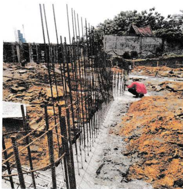
Gambar 3.2.15 Pembesian shear wall
