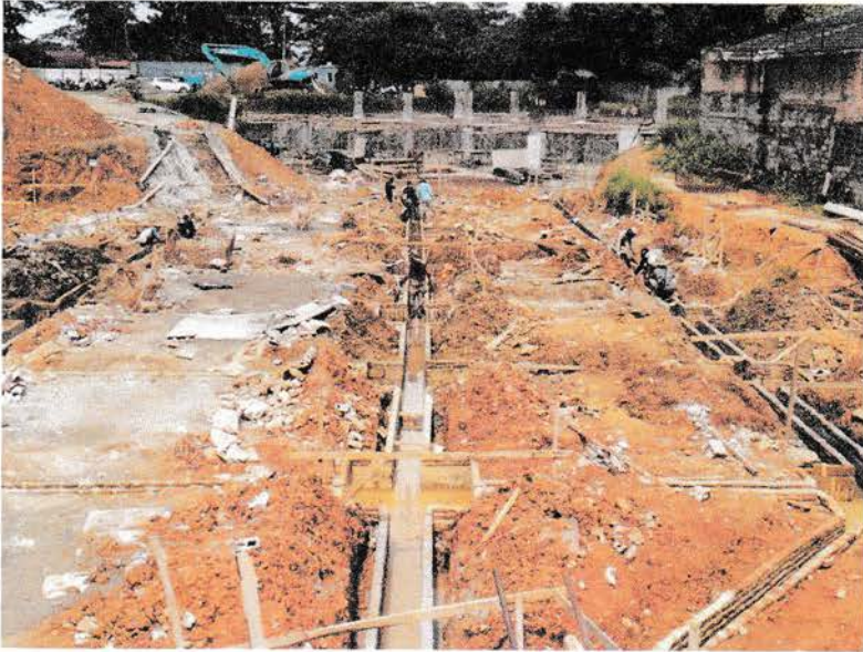
Gambar Pekerjaan penulangan sloof basement 1
