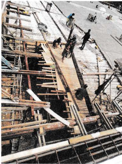
Gambar pekerjaan penulangan plat lantai basement 2
