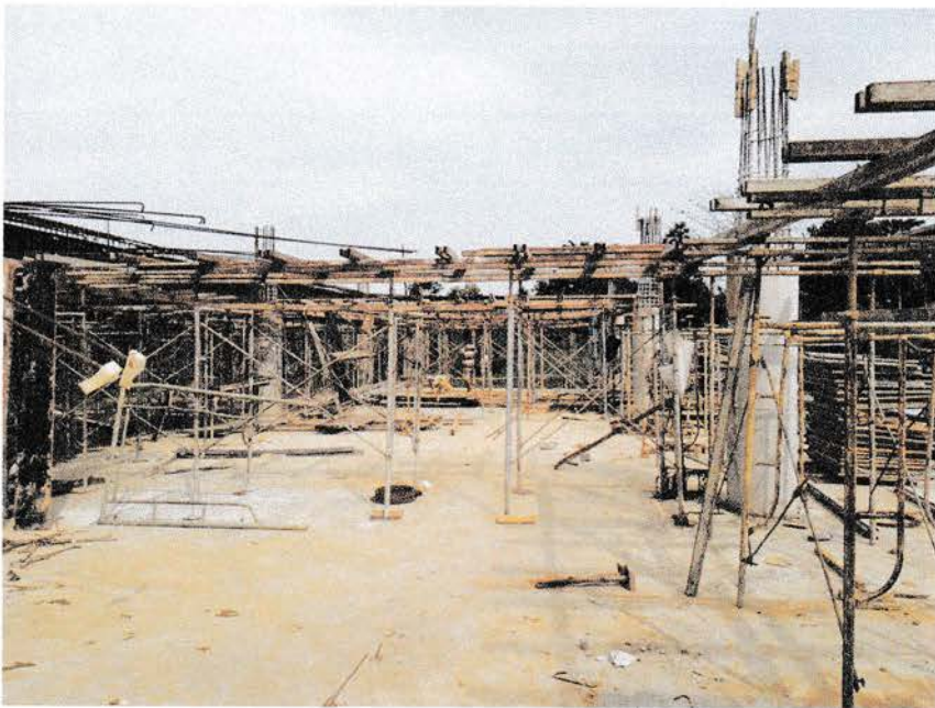
Gambar 3.2.19 Penyusunan Scaffolding ( perancah ) sebagai struktur sementara
