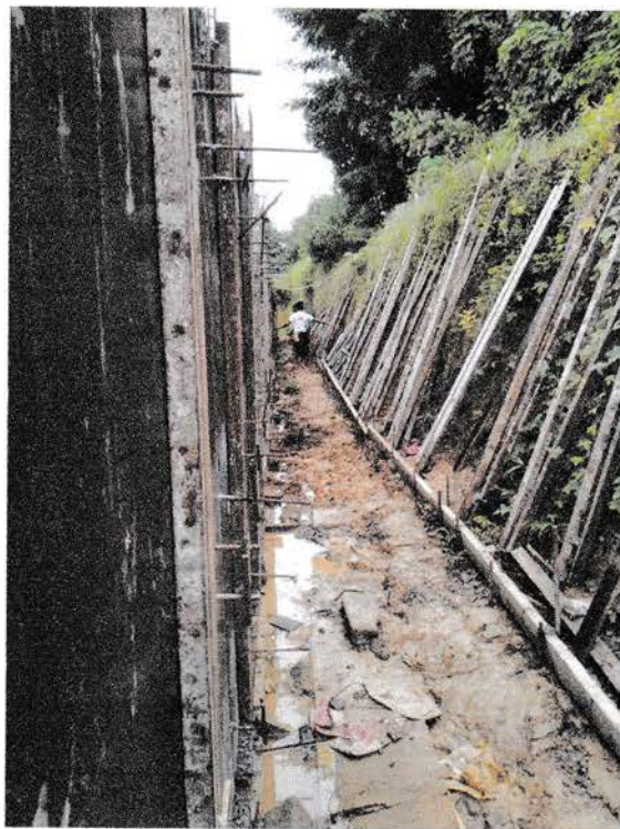
Gambar 3.2.16 Pekerjaan pemasangan bekisting shear wall
