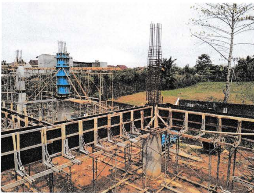
Gambar 3.2.20 Bekisting balok dengan struktur scaffolding di bawah nya UNIVERSITAS MEDAN AREA
