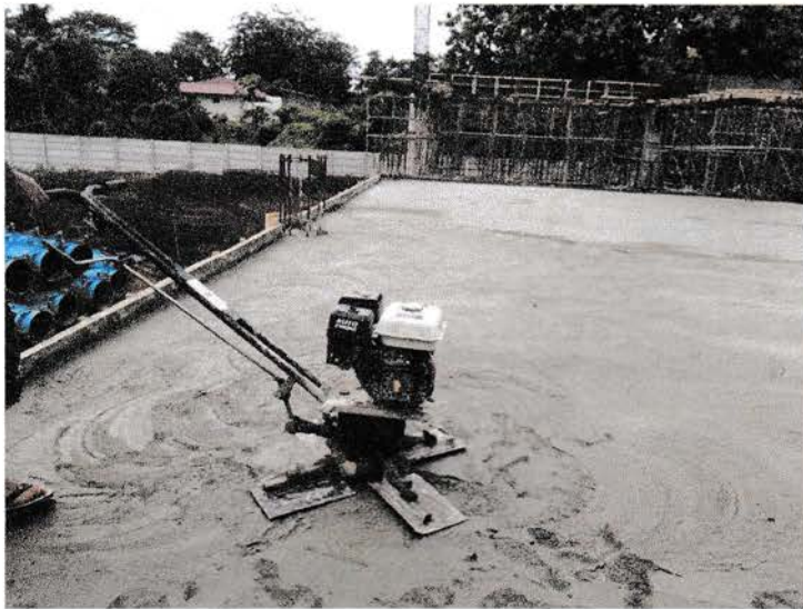
Gambar 3.1.7 Mesin trowel
