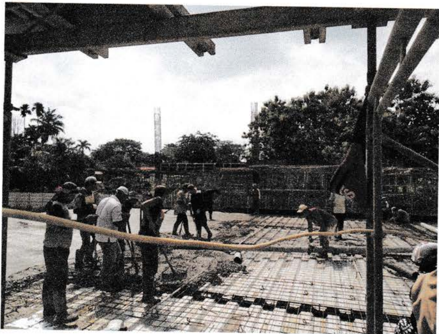
Gambar 3.2.26 Proses pengecoran balok dan plat lantai
