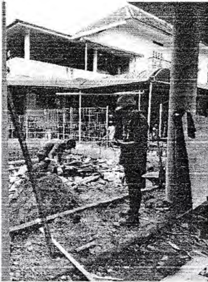
Gambar 4. Proses Pemasangan Dinding No.2 Campuran Pasir dan Semen (mortar)
