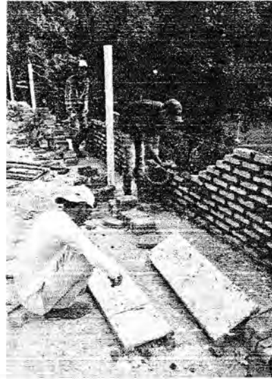
Gambar 5. Proses Pemasangan Dinding No.3 Taruh Adukan Mortar ke Atas
