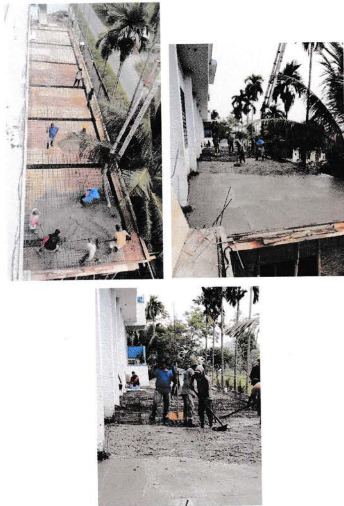
Gambar 3.3 Pengecoran Ring Balok
