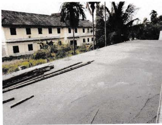
Gambar 3.4 Pembongkaran Bekisting
