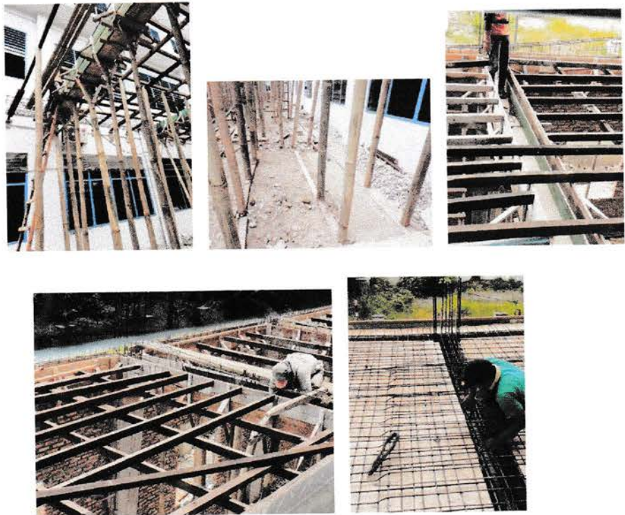
Gambar 3.2 Pemasangan & Pembuatan Bekisting
