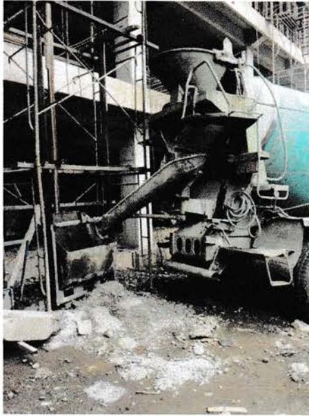
Gambar 4. Proses Penuangan Ready Mix ke Lift Bucket
