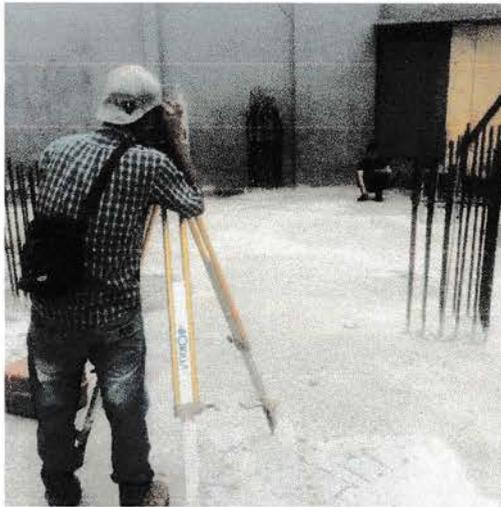
Gambar 1. Penentuan *As* dengan *Theodolit*
