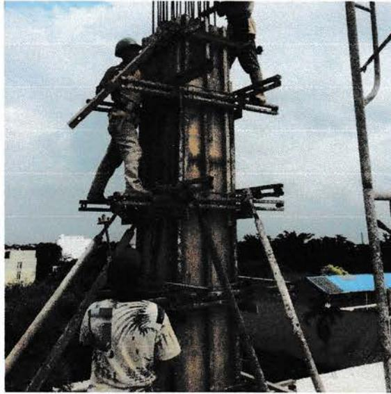
Gambar 3.3.6 Pemasangan Bekisting Kolom
