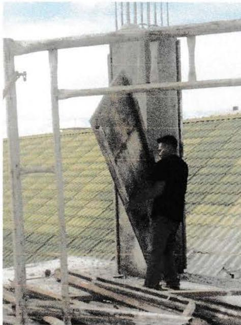
Gambar 5. Pelepasan Bekisting Kolom
