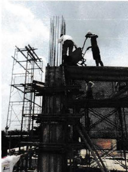
Gambar 4. Penuangan Beton ke dalam Bekisting
