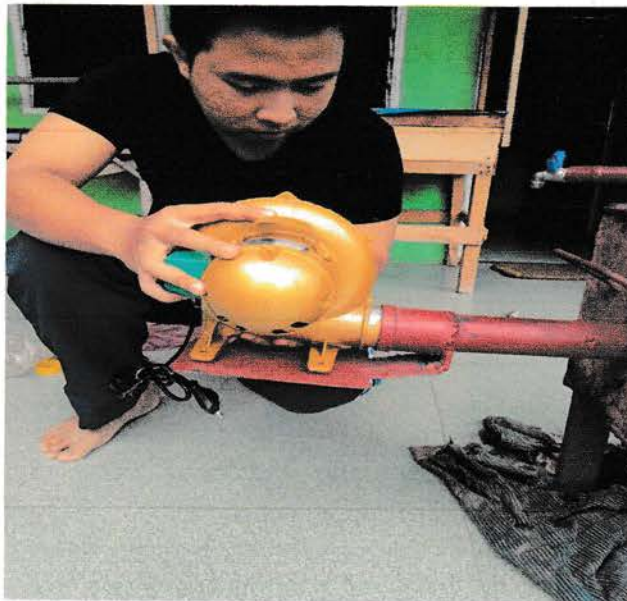
Gambar 4.2.2.7 pemasangan blower pada ruang bakar
