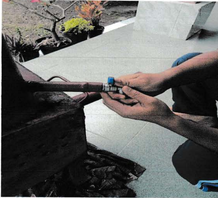
Gambar 4.2.2.6 pemasangan kran air
