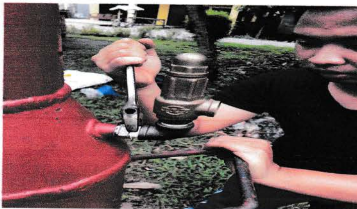
Gambar 4.2.2.1 Pemasangan safety valve
