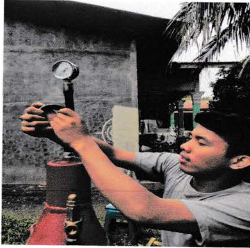
Gambar 4.2.2.4 Pemasangan sippon dan presure gauge
