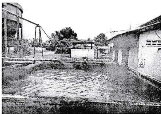
Gambar 3. 80 Bak Sedimentasi
