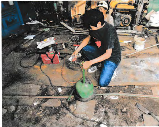
gambar 4.1. proses pengerjaan (fahmi fahrezi manurung)
