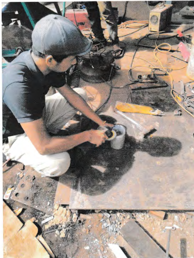
gambar 4.2. proses pengerjaan ( Jerico Marpaung)
