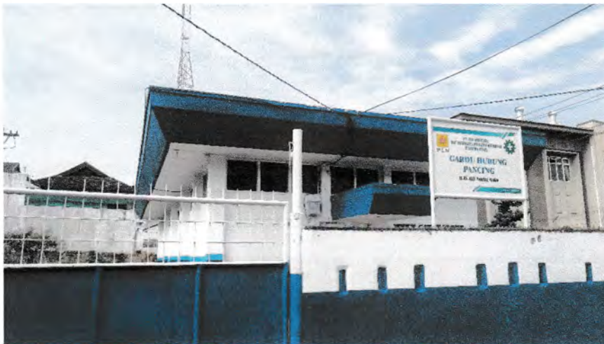
Gambar 3.6 Bangunan Gardu Beton (Sumber : Penulis, 2019)
