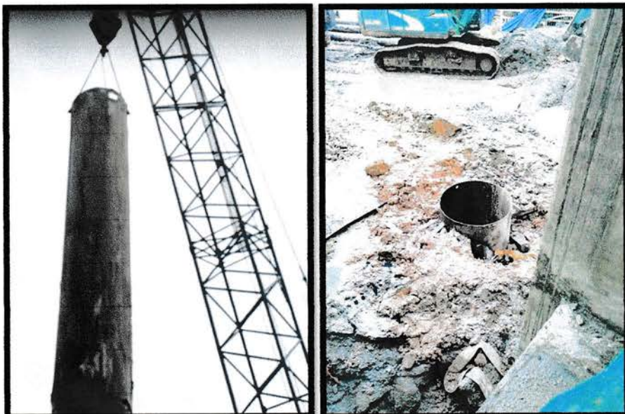
Gambar 8. Pemasangan casing
