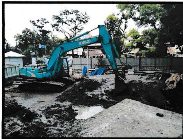
Gambar 14. Proses pembuangan tanah hasil bor
