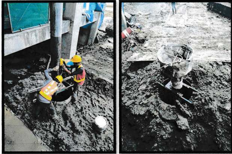
Gambar 11. Pemasangan pipa tremi dan bucket cor
