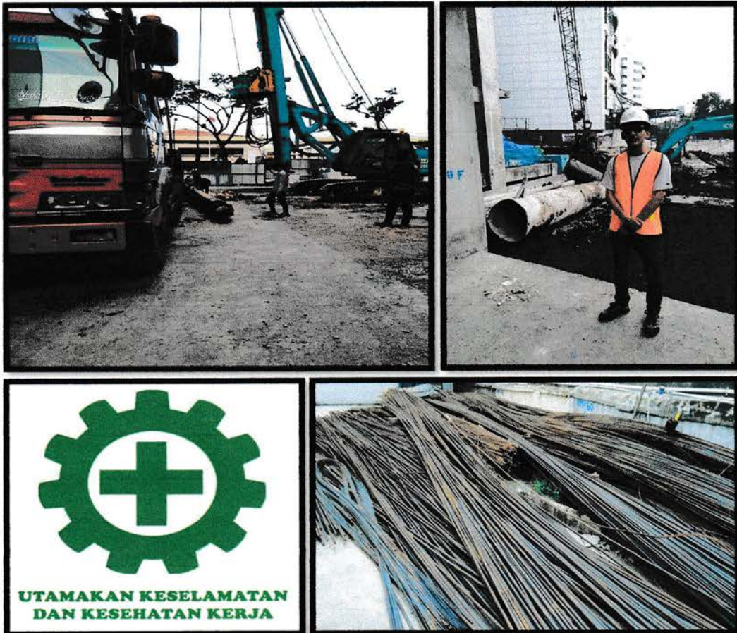
Gambar 3. Persiapan lahan, alat, bahan, tenaga kerja dan K3L
