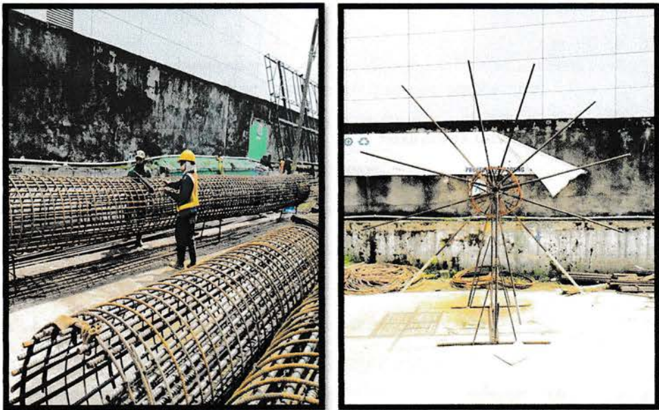
Gambar 6. Perakitan besi tulangan bored pile
