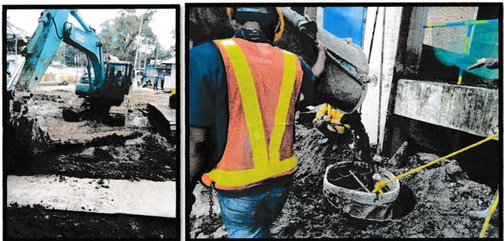
Gambar 12. Persiapan pengecoran dan pengecoran
