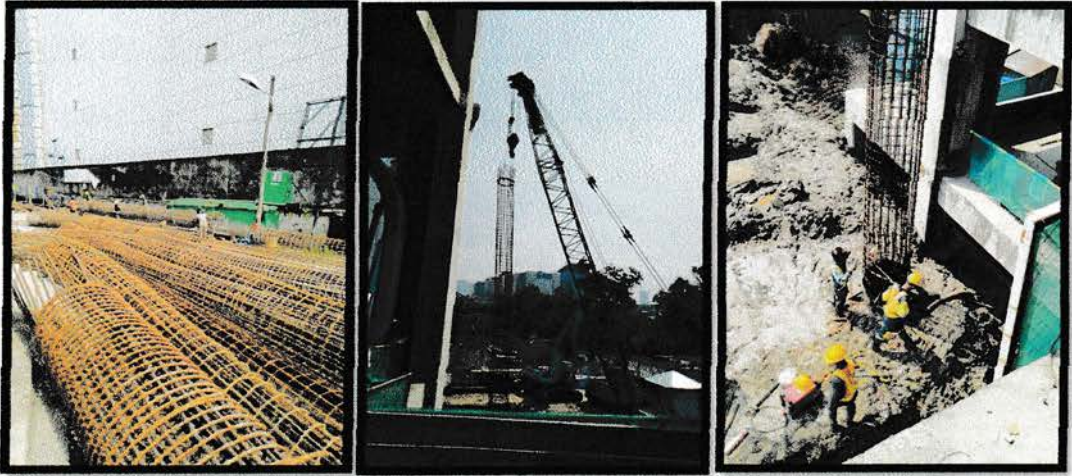
Gambar 10. Pemasangan besi tulangan
