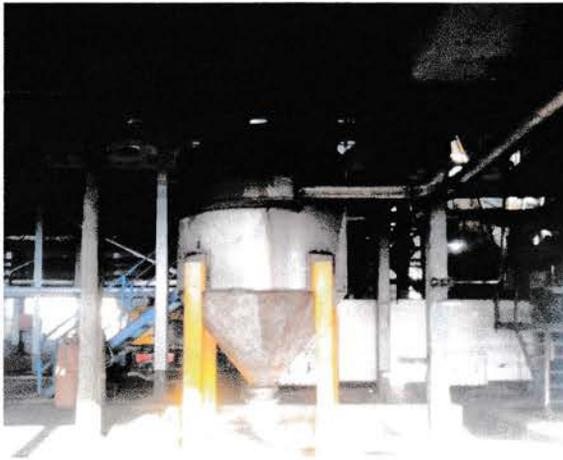
Gambar 3.4. *Sand Trap Tank*
