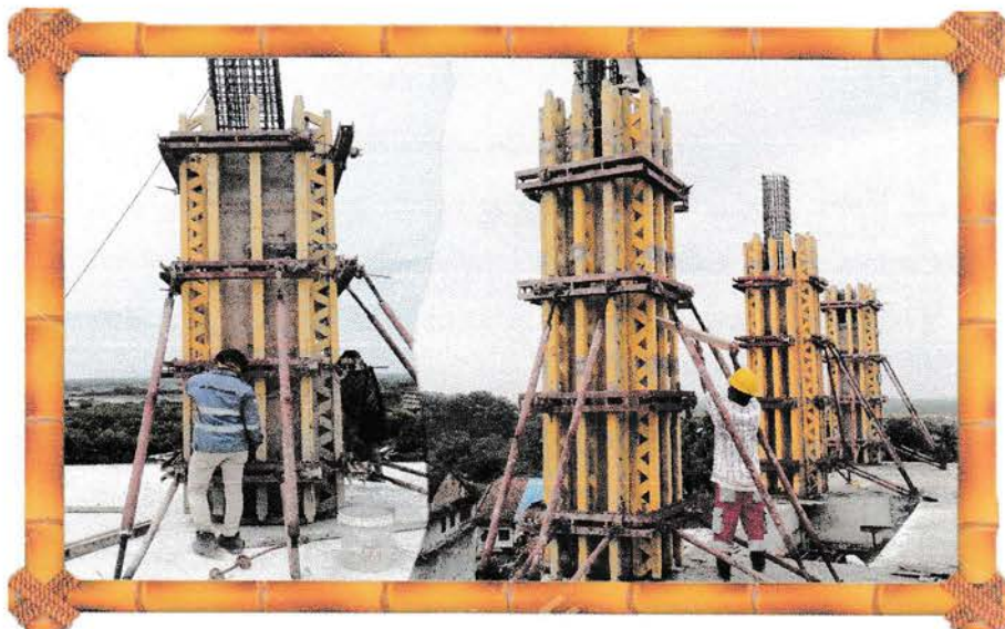
Gambar III. 20 Pemasangan bekisting
