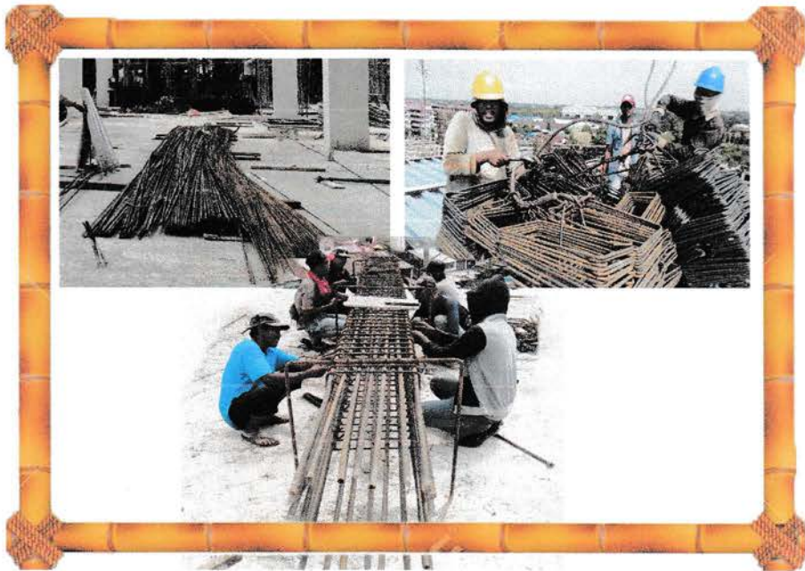
Gambar III. 16 Besi Ulir dirakit menjadi rangka kolom
