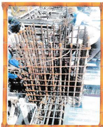
Gambar III. 25 pengerjaan sambungan kolom dengan Balok
