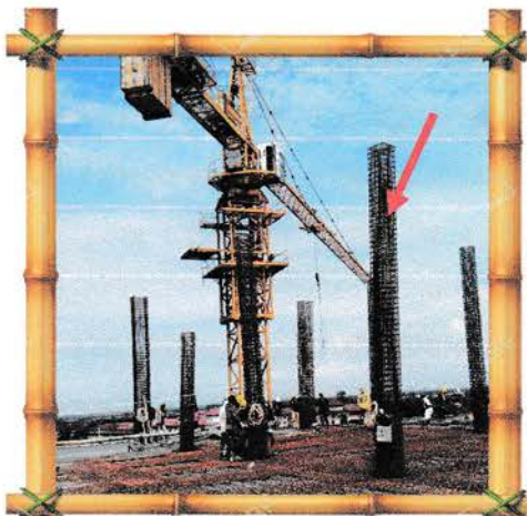
Gambar III. 18 Tulangan Kolom Utama
