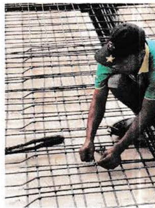
Membengkokkan besi tromol pada Dak Beton
