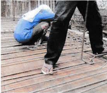
Membengkokkan besi tromol pada Dak Beton
