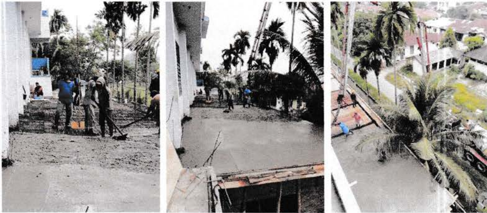
Beton yang telah dituang diratakan dengan penggaruk (papan perata)
