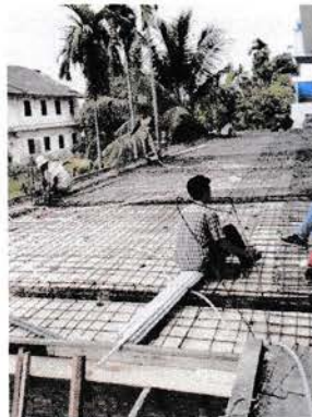
Pemasangan Pipa Elektrikal
