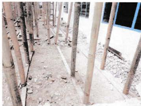
Pemasangan Bekisting
