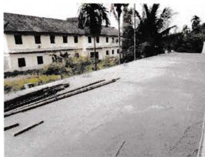
Pemberian acian semen sebagai penutup pori pada Dak Beton
