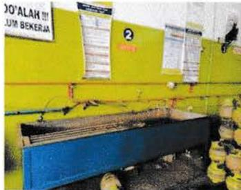
**Gambar 3.7 Bak air dan instalasi angin**
