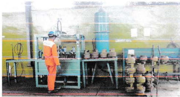
Gambar 3.4. Leak Teast Awal
