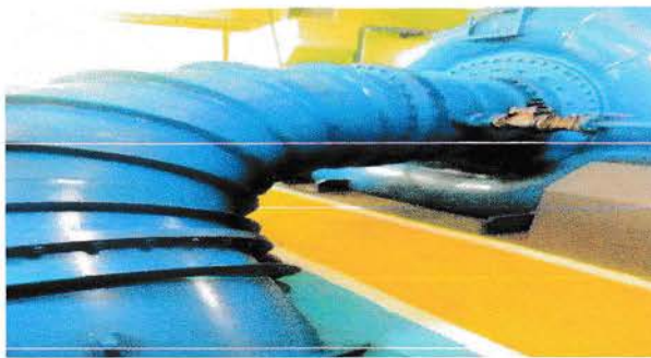
Gambar 3. 2 : Spiral casing dan stay vanering
