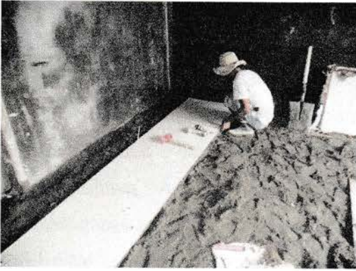
Gambar 6. Proses Pemasangan Keramik
