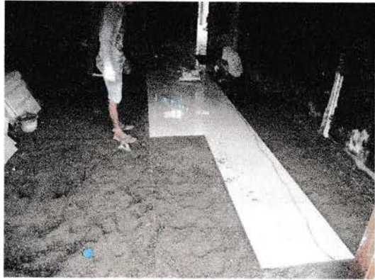
Gambar 7. Proses Pemasangan Keramik
