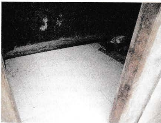
Gambar 10. Proses Akhir Pemasangan Lantai Keramik
