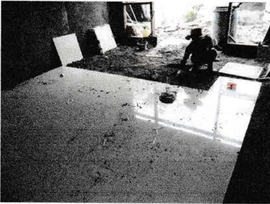
Gambar 8. Proses Pemasangan Keramik
