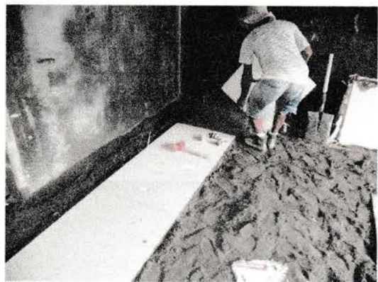
Gambar 5. Proses Pemasangan Keramik No.3 Taruh Adukan Mortar ke Dasar Lantai
