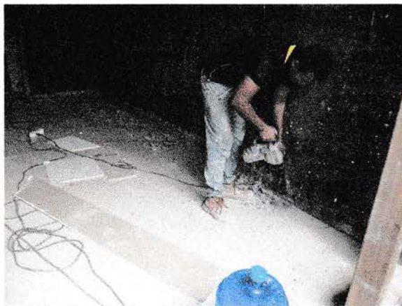
Gambar 3. Proses Pemasangan Keramik No.11 Pemasangan Keramik Pada Ujung Baris
