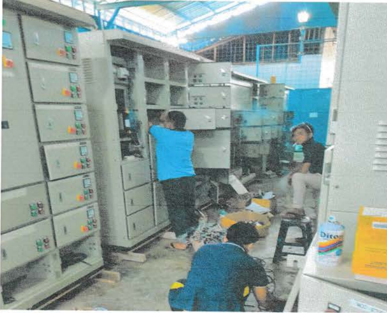
Gambar 3.3 Pemeliharaan Rutin setaip 6 bulan sekali secara manual
