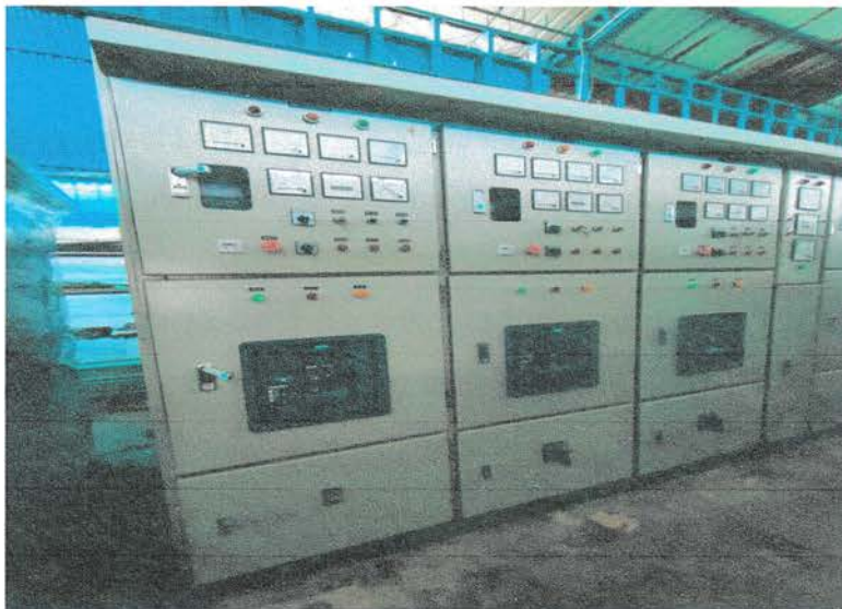
Gambar 3.1 Panel daya tertutup bentuk lemari
