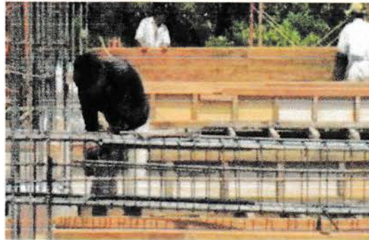
Gambar 5. Perakitan Penulangan Balok
