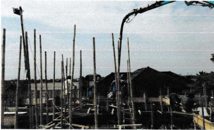
Gambar 1. Pengecoran balok lantai
