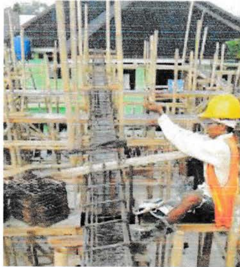
Gambar 2. Pemasangan Bekisting
