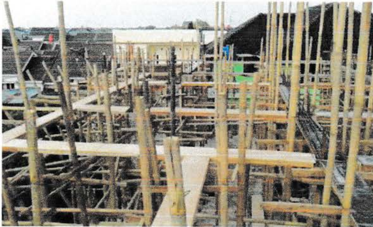
Gambar 1. Pemasangan Bambu Penyangga
