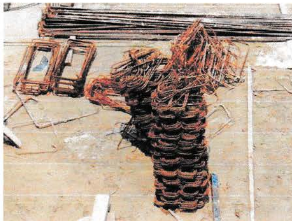
Gambar 5. Tulangan Sengkang/Beugel yang Telah dirakit
