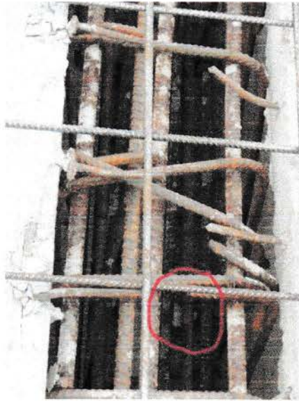
Gambar 6. b Penggunaan Beton Deckin
