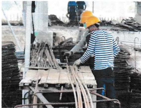
Gambar 4. Pembengkokan Besi Untuk Membentuk Beugel
