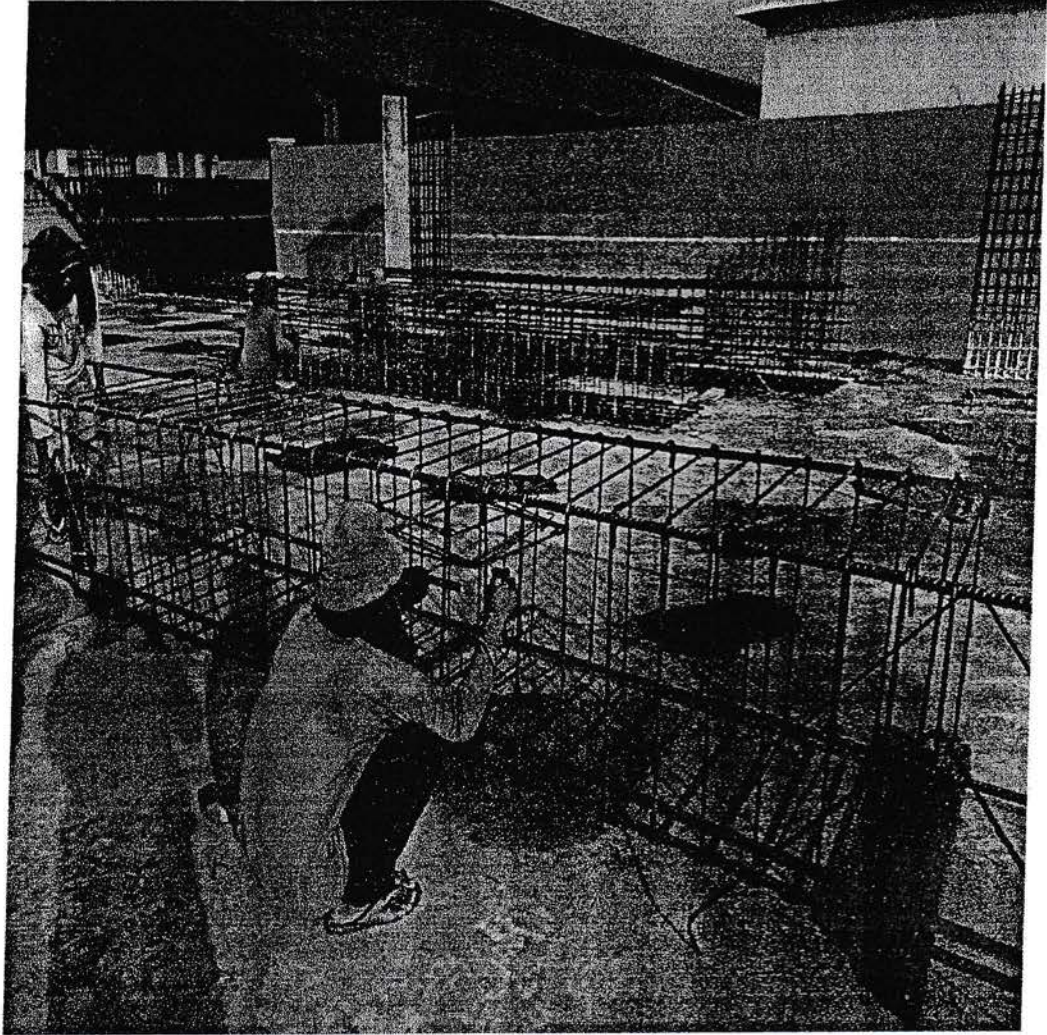
Pekerjaan Pengikatan Tulangan Kolom
