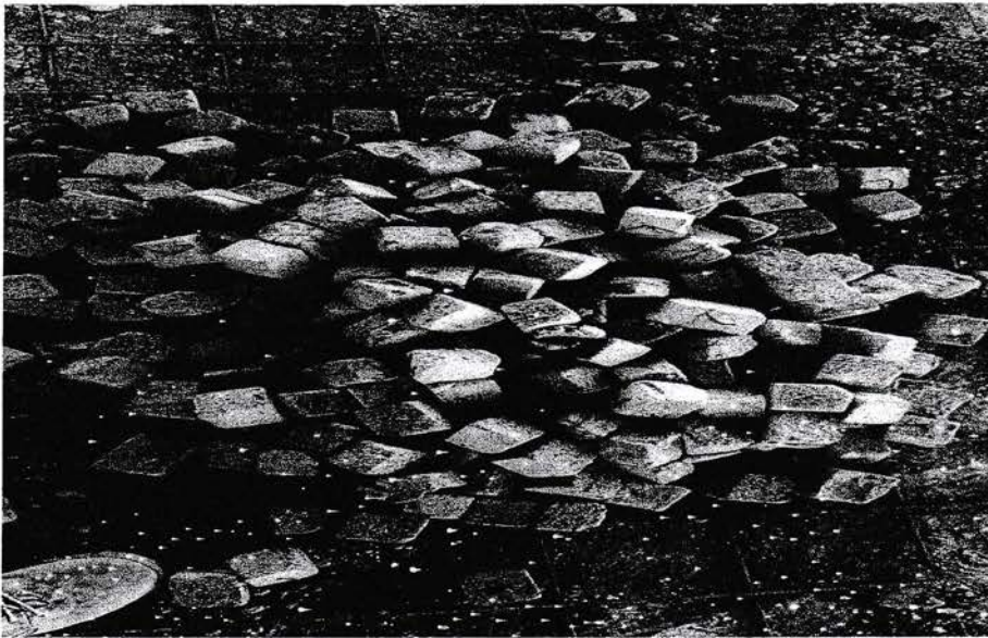
Gambar 3 : Tahu beton (Beton Decking)
