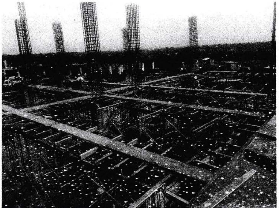
Gambar 3.24. Proses pemasangan bekisting balok
