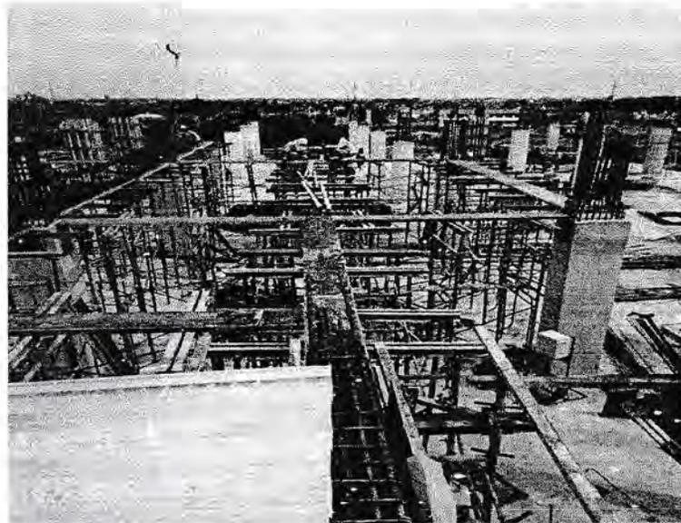
Gambar 3.10 Pemasangan Bekisting Balok dan Plat Lantai
