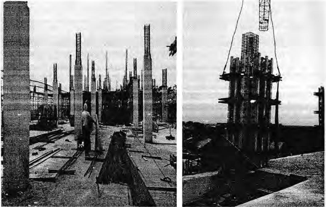
Gambar 5. Pembongkara Bekisting Setelah Beton Mengeras
