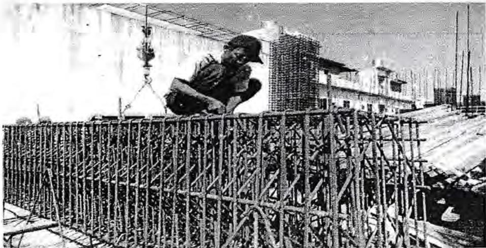
Gambar 3.16 Pekerjaan pemotongan dan pembengkokan tulangan
